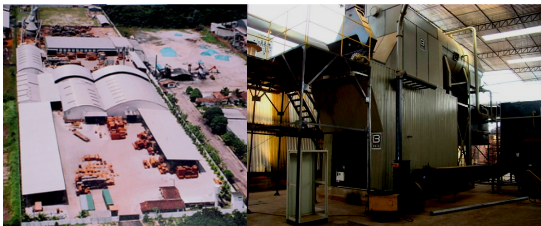
Figura 1: Vista aérea da planta industrial e caldeira da usina de geração de energia.
