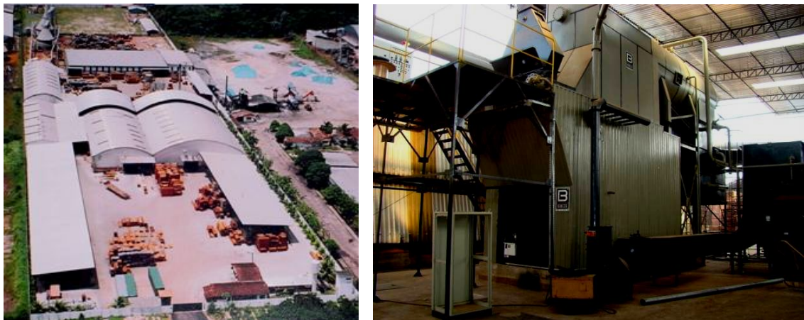
Figura 1: Vista aérea da planta industrial e caldeira da usina de geração de energia.
