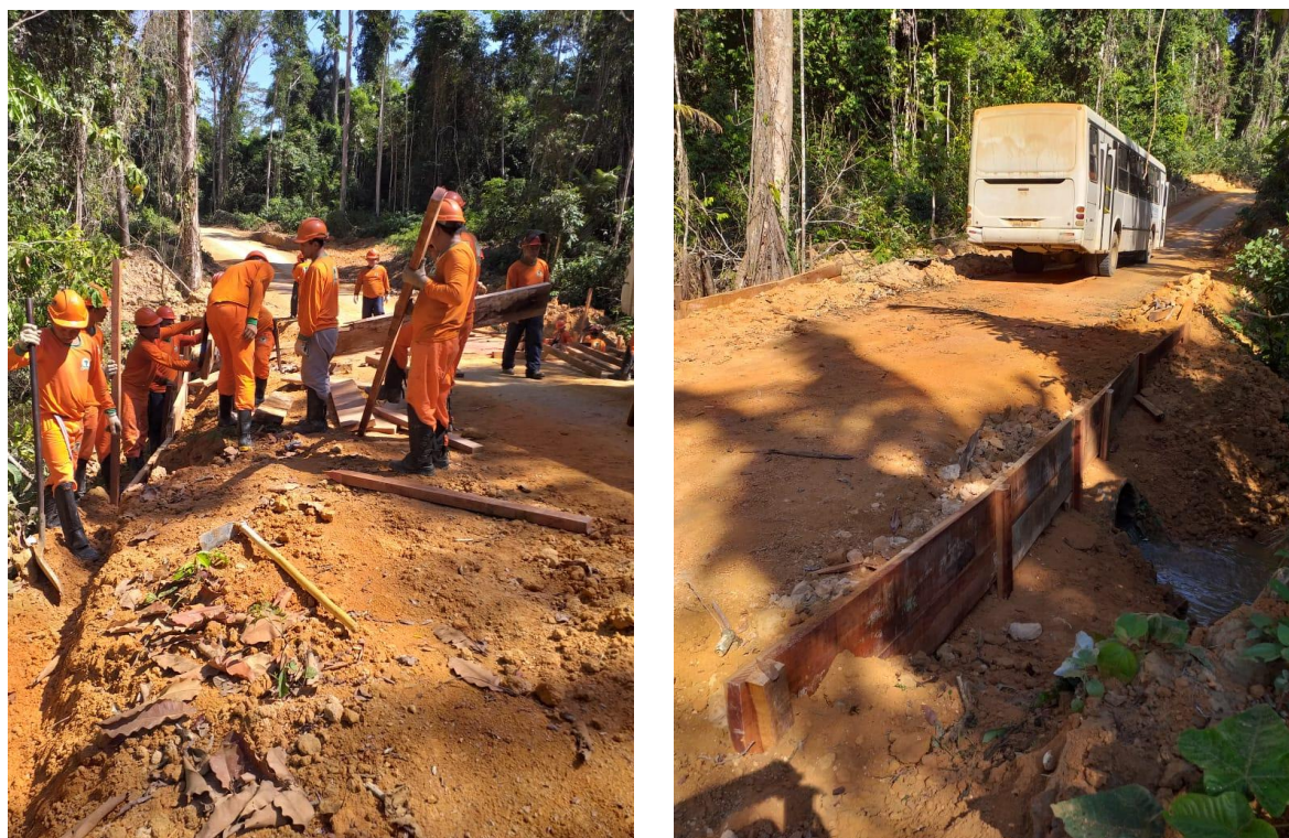
Figura 49: Construção de Murro de Arrimo na lateral da estrada.
