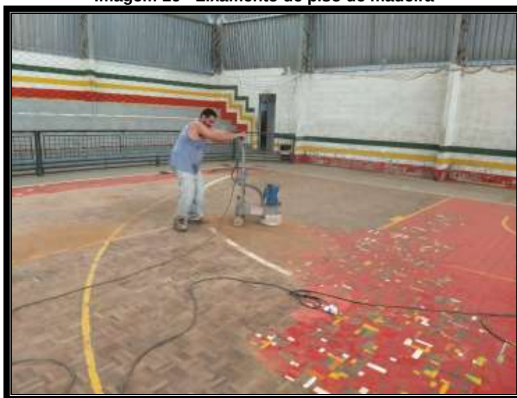
Imagem 16 - Lixamento de piso de madeira
