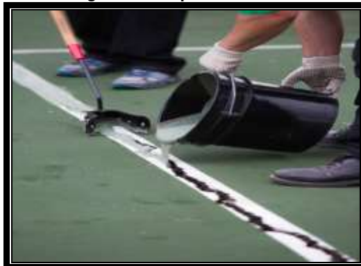
Imagem 10 - Reparo de buraco
