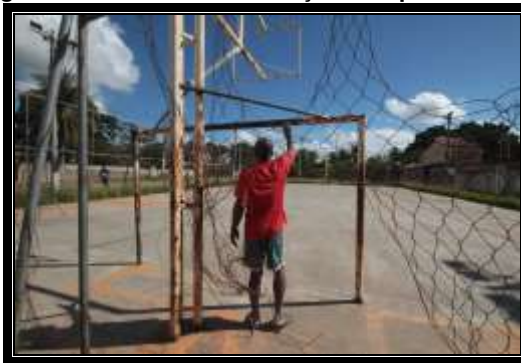
Imagem 27 - Falta de manutenção em quadra.
