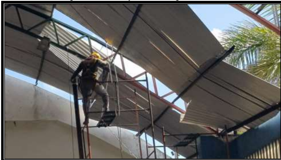
Imagem 30 - Manutenção de teto de ginásio
