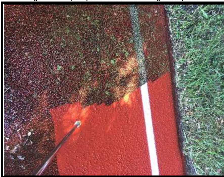
Imagem 12 - Limpeza pista de atletismo com água sob pressão
