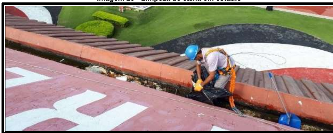
Imagem 29 - Limpeza de calha em estádio
