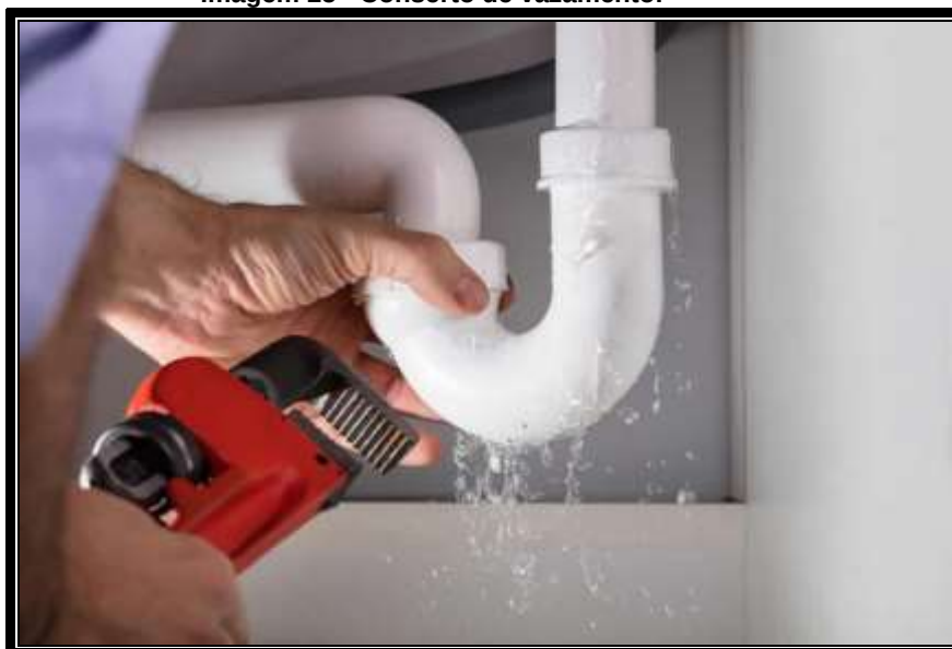
Imagem 25 - Conserto de vazamento.
