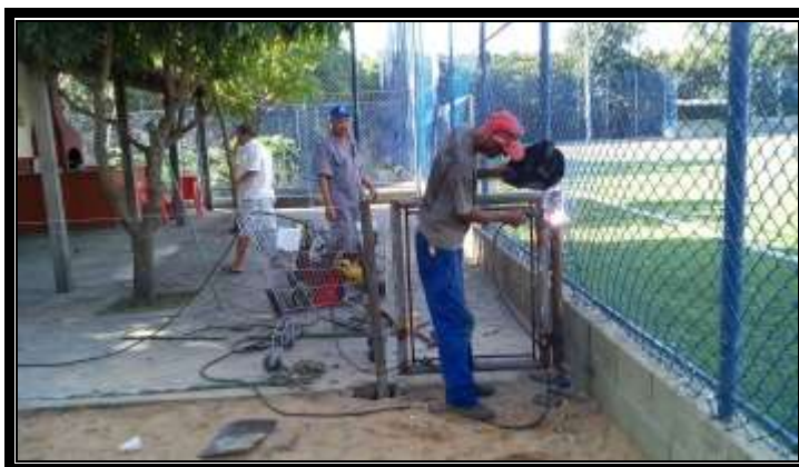
Imagem 20 – Manutenção de alambrado de campo de futebol
