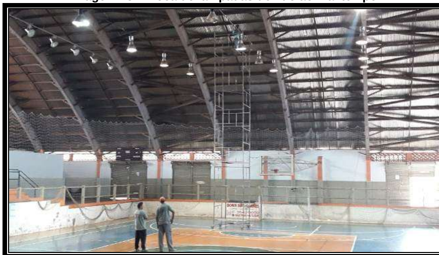
Imagem 23 - Troca de lâmpadas devido ao mal tempo
