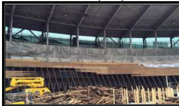
Imagem 16 – foto ilustrativa da manutenção da pista de rolamento de um velódromo
