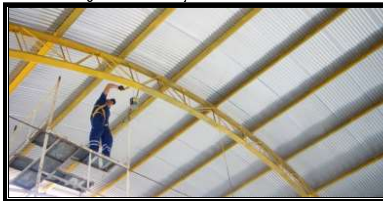
Imagem 21 - Manutenção de estrutura metálica.
