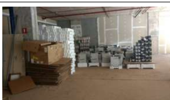
Foto 6: Espaço inacabado do Pavimento “0” (Semienterrado), para o qual estava prevista a instalação de restaurante e banco, espaço esse que está sendo utilizado como depósito. Brasília (DF), 20 de fevereiro de 2017.
