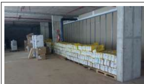
Foto 7: Espaço inacabado do Pavimento “0” (Semienterrado), para o qual estava prevista a instalação de restaurante e banco, espaço esse que está sendo utilizado como depósito. Brasília (DF), 20 de fevereiro de 2017.
