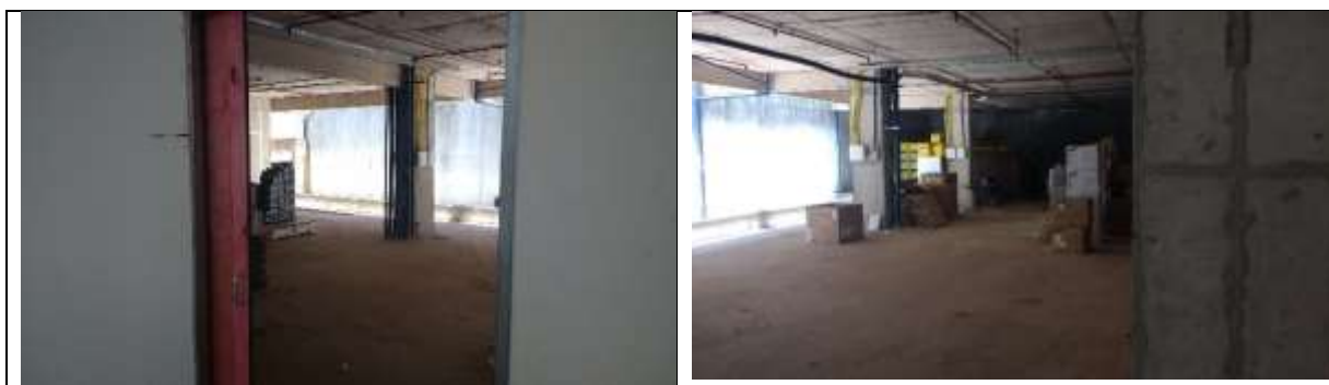
Imóvel SIG 04 - Pavimento Semienterrado (Andar “-1”):
