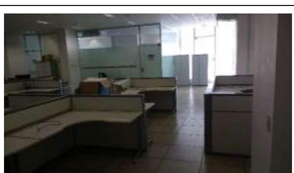
Foto 8: Sala identificada como “Reprografia”, localizada no Pavimento “0” (Semienterrado), cujas instalações ainda não se encontravam em utilização. Brasília (DF), 20 de fevereiro de 2017.
