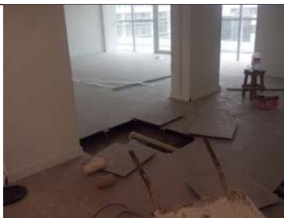
Foto 8: Pavimento Cobertura em obras e sem ocupação, cujas salas ainda não se encontravam identificadas, em 23 de novembro de 2015.
