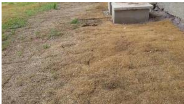
Foto 17– Grama aplicada sem regularização do terreno e em desacordo com projeto de paisagismo, Maceió/AL, 23 de fevereiro de 2015.
