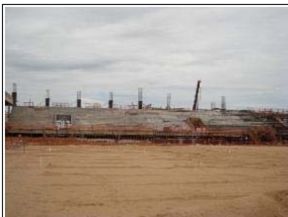
Visão geral da arquibancada e campo de futebol.
