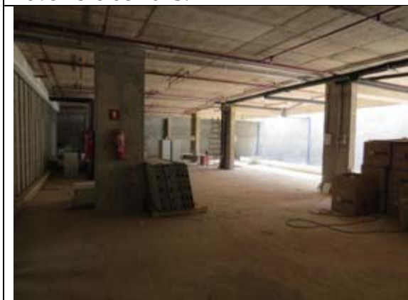
Foto 9: Salas destinadas a Banco e Museu, no Pavimento Semienterrado, em obras e sem ocupação, em 22 de dezembro de 2015.
