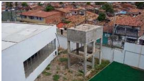
Foto 01– Reservatório elevado inacabado, Maceió/AL, 23 de fevereiro de 2015.
