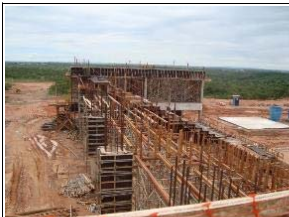
Arquibancada em construção.
