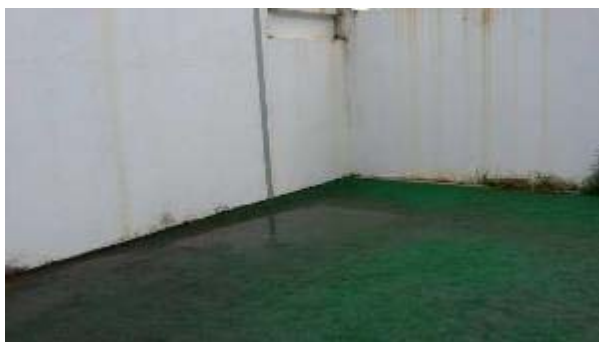
Foto 15 – Drenagem do campo de futebol deficiente, Maceió/AL, 23 de fevereiro de 2015.
