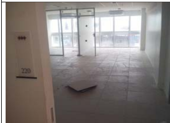
Foto 5: Sala do Pavimento 2 em manutenção e sem ocupação, cuja porta de acesso estava identificada como "220", em 23 de novembro de 2015.
