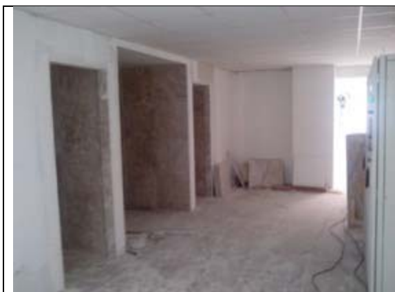
Foto 7: Pavimento Cobertura em obras e sem ocupação, cujas salas ainda não se encontravam identificadas, em 23 de novembro de 2015.
