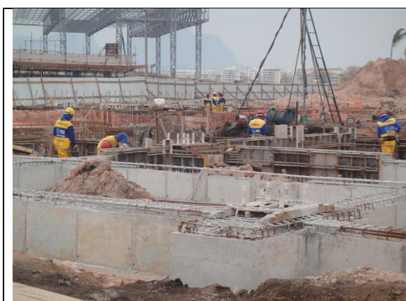
Foto 9 – Vigas de amarração – 26 de setembro de 2014.
