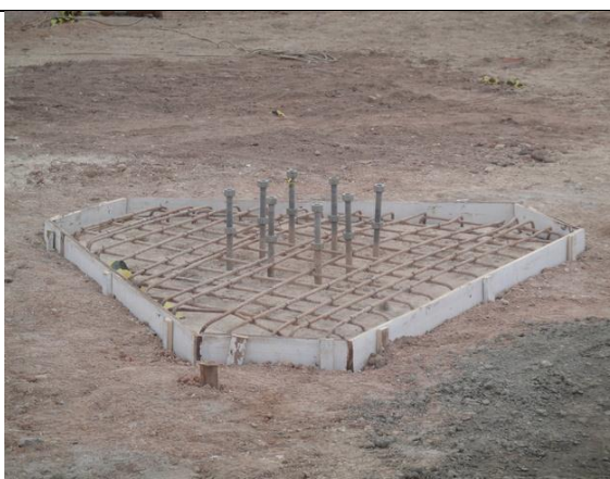
Foto 10 – Bloco de fundação - 26 de setembro de 2014.
