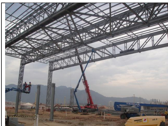
Foto 9 – Estrutura de metálica - 26 de setembro de 2014.
