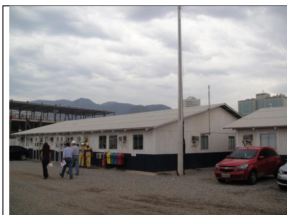
Foto 3 – Barracão de Obra – 26 de
