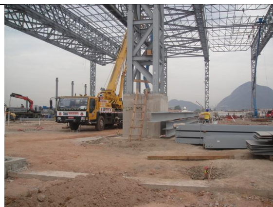
Foto 6 – Estrutura metálica - 26 de setembro de 2014.
