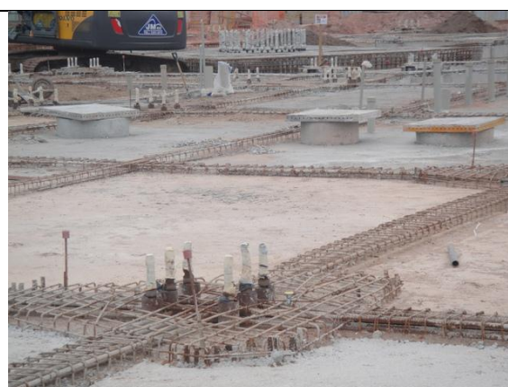
Foto 10 – Vigas de amarração – 26 de setembro de 2014.
