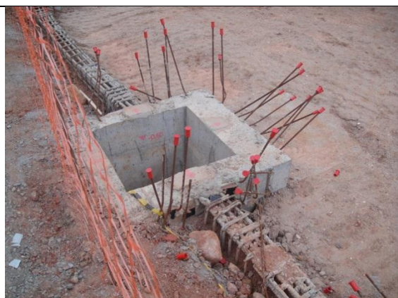
Foto 15 – Fundação da arquibancada – 26 de setembro de 2014.
