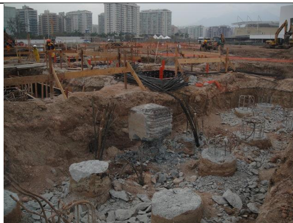
Foto 6 – Cabeças das estacas – 26 de setembro de 2014.
