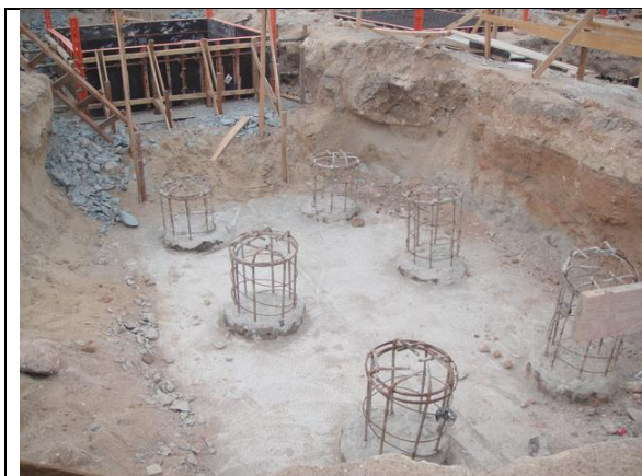
Foto 5 – Cabeças das estacas – 26 de setembro de 2014.
