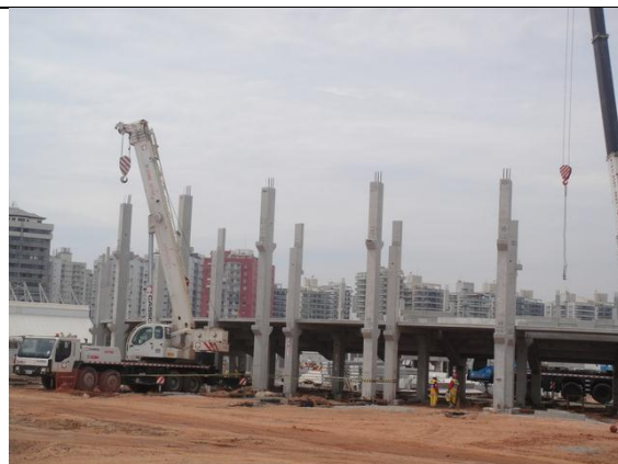
Foto 12 – Vista externa Arena 1 – 26 de setembro de 2014.
