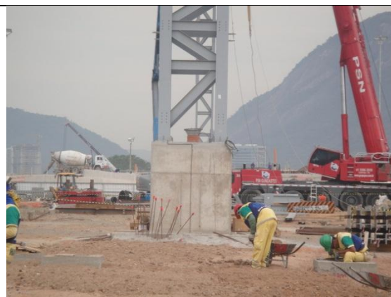
Foto 4 – Estrutura metálica e bloco - 26 de setembro de 2014.
