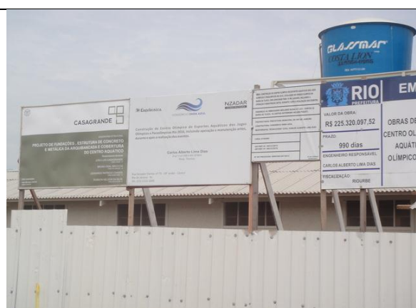
Foto 2 – Placa de Obra – 26 de setembro de 2014.
