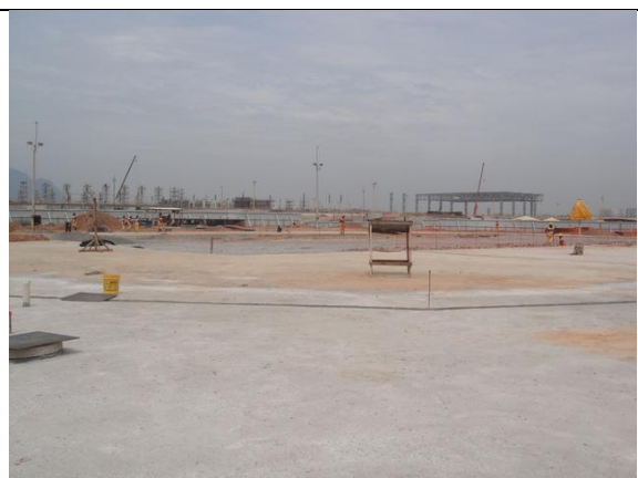
Foto 9 – Base de arena provisória – 26 de setembro de 2014.
