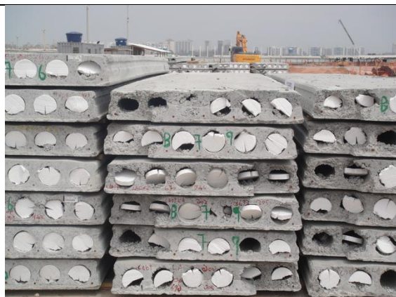
Foto 11 – Placas pré-moldadas – 26 de setembro de 2014.
