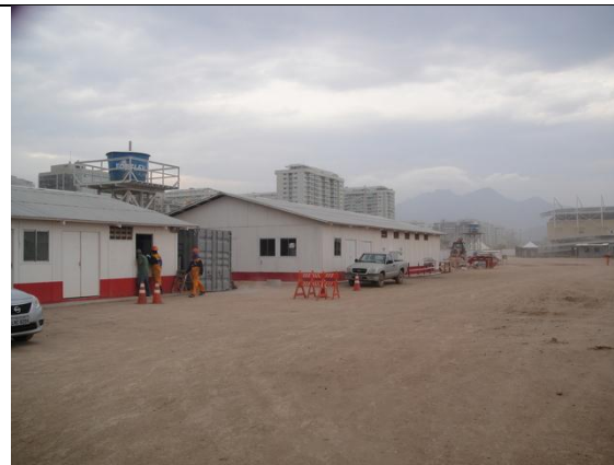
Foto 2 – Barracão de Obra – 26 de setembro de 2014.
