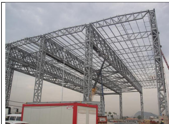
Foto 3 – Estrutura metálica - 26 de setembro de 2014.
