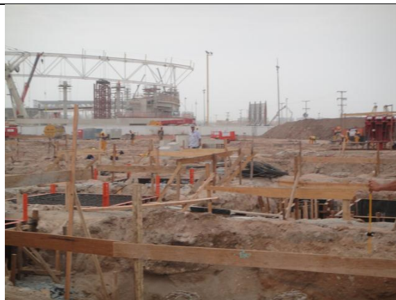
Foto 4 – Estrutura metálica e bloco – 26 de setembro de 2014.
