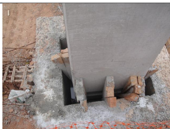
Foto 14 – Pilar e bloco – 26 de setembro de 2014.
