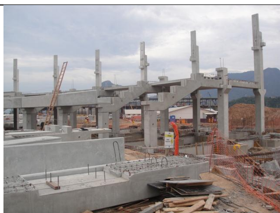
Foto 13 – Estrutura da arquibancada – 26 de setembro de 2014.
