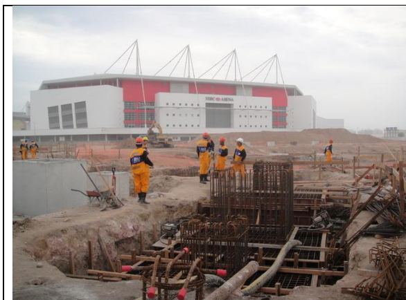
Foto 3 – Estrutura metálica – 26 de setembro de 2014.
