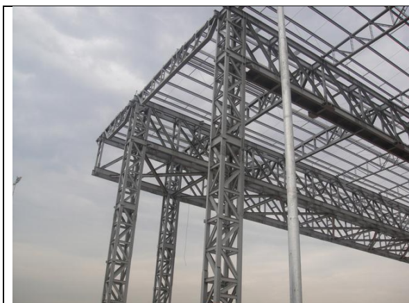
Foto 5 – Estrutura metálica - 26 de setembro de 2014.
