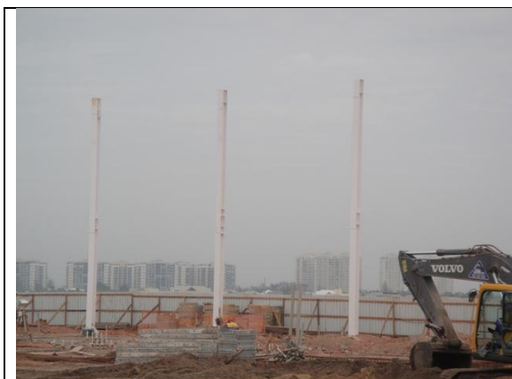
Foto 11 – Pilares metálicos – 26 de setembro de 2014.
