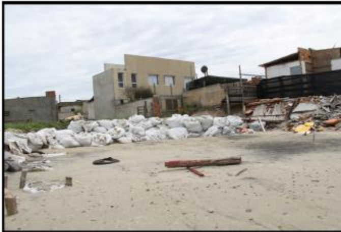
FIG. 29 – Sacos de areia, alguns sacos estavam com cimentos, se assemelhando a obra do tipo bagwall .
