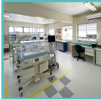
Infraestrutura Engenharia Clínica
