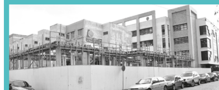
2013 - Obras do Prédio Anexo
