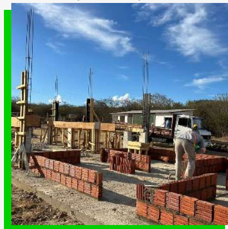
Construção de Estação Elevatória
