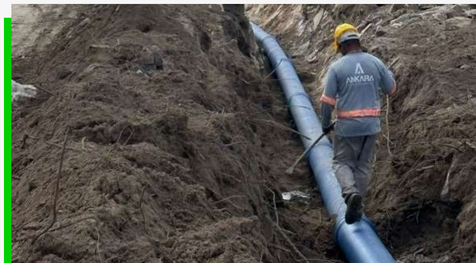
Assentamento de tubos
