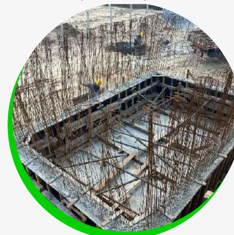
Construção de Estação Elevatória
