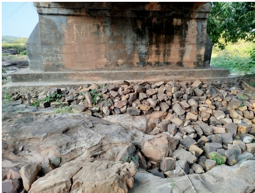
Figura 2 - Vista frontal da sapata da ponte sob o vertedouro da Barragem, onde foi colocado o enrocamento visível na propositura de proteção provisória da mesma - Latitude: 4°19'58'', Longitude: 41°46'20''
