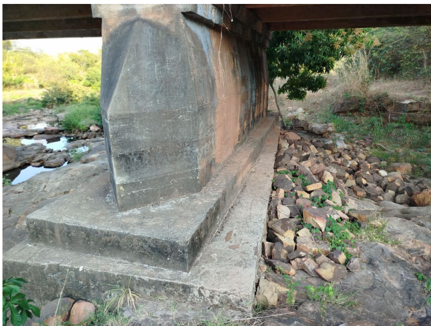
Figura 3 - Vista lateral da sapata da ponte sob o vertedouro da Barragem, onde foi colocado o enrocamento visível na propositura de proteção provisória da mesma - Latitude: 4°19'58'', Longitude: 41°46'20''
