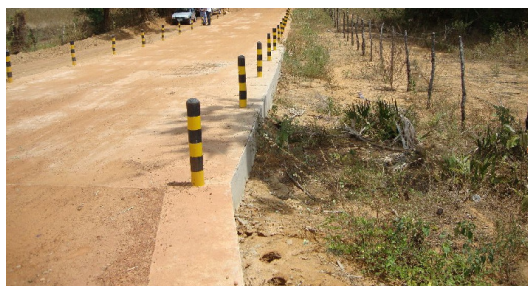
Obra Lote 2 concluída
