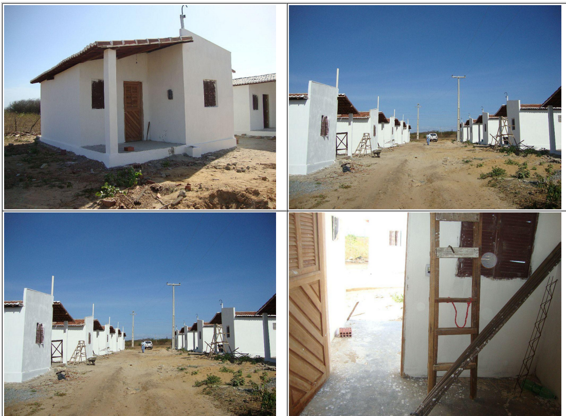
Conv. 657313 – Construção de casas
