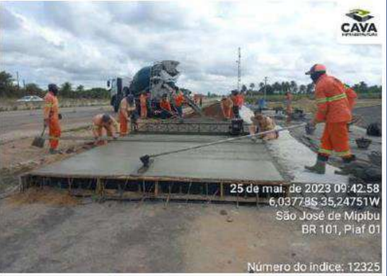
Data: 25/05/2023 LOCAL: PIAF 14.01.101 RN Serviço: Concretagem - Pista de Aceleração
