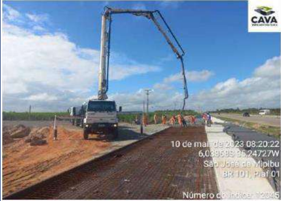
Data: 10/05/2023 LOCAL: PIAF 14.01.101 RN Serviço: Concretagem - Pista de Desaceleração
