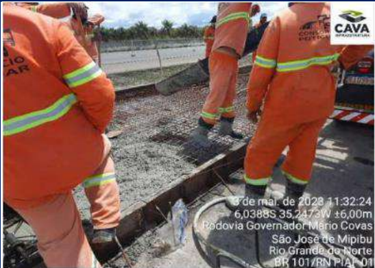
Data: 03/05/2023 LOCAL: PIAF 14.01.101 RN Serviço: Concretagem - Pista de Desaceleração
