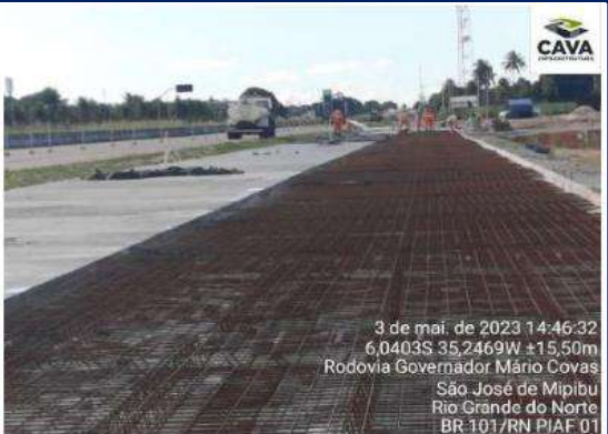
Data: 03/05/2023 LOCAL: PIAF 14.01.101 RN Serviço: Montagem de forma e armação - Pista de Desaceleração
