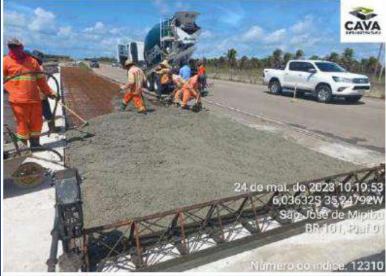
Data: 24/05/2023 LOCAL: PIAF 14.01.101 RN Serviço: Concretagem - Pista de Aceleração
