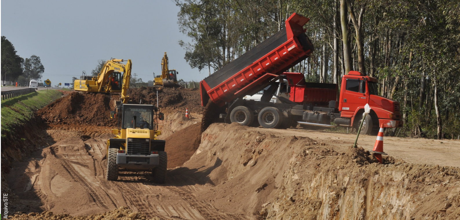
Máquinas dão forma à nova pista da BR-116/392
