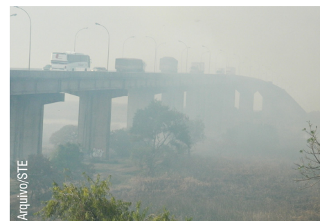
Queimada na Várzea do Canal São Gonçalo prejudicou a visibilidade dos motoristas que trafegavam na BR-392
