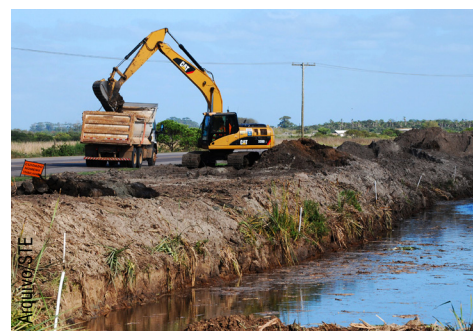
Solos moles são retirados para a colocação do aterro e destinados às jazidas
