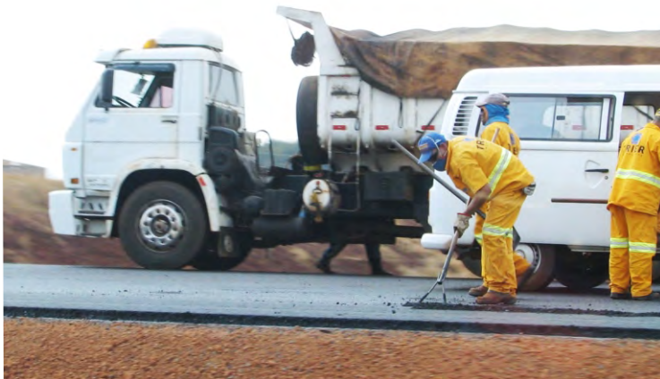
Trabalhadores na obra de duplicação da BR-060.
