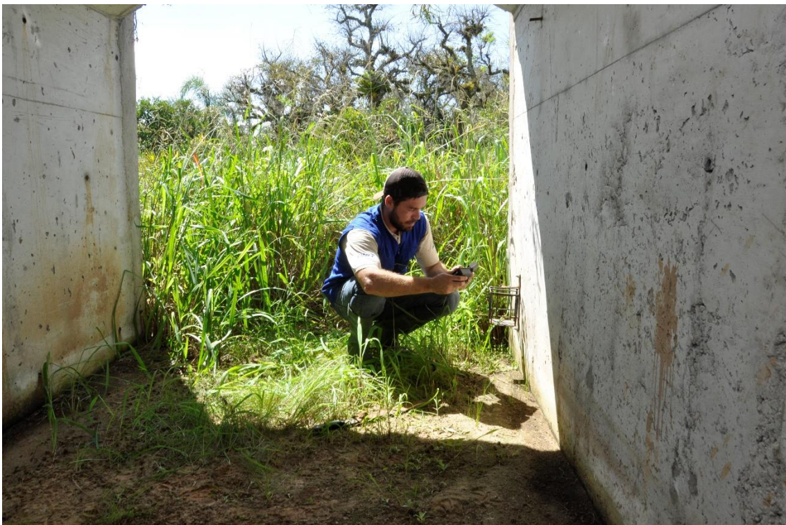
Verificação do monitoramento 24 horas por câmera, em passagem de fauna seca na BR-116/392/RS, no município de Pelotas.
