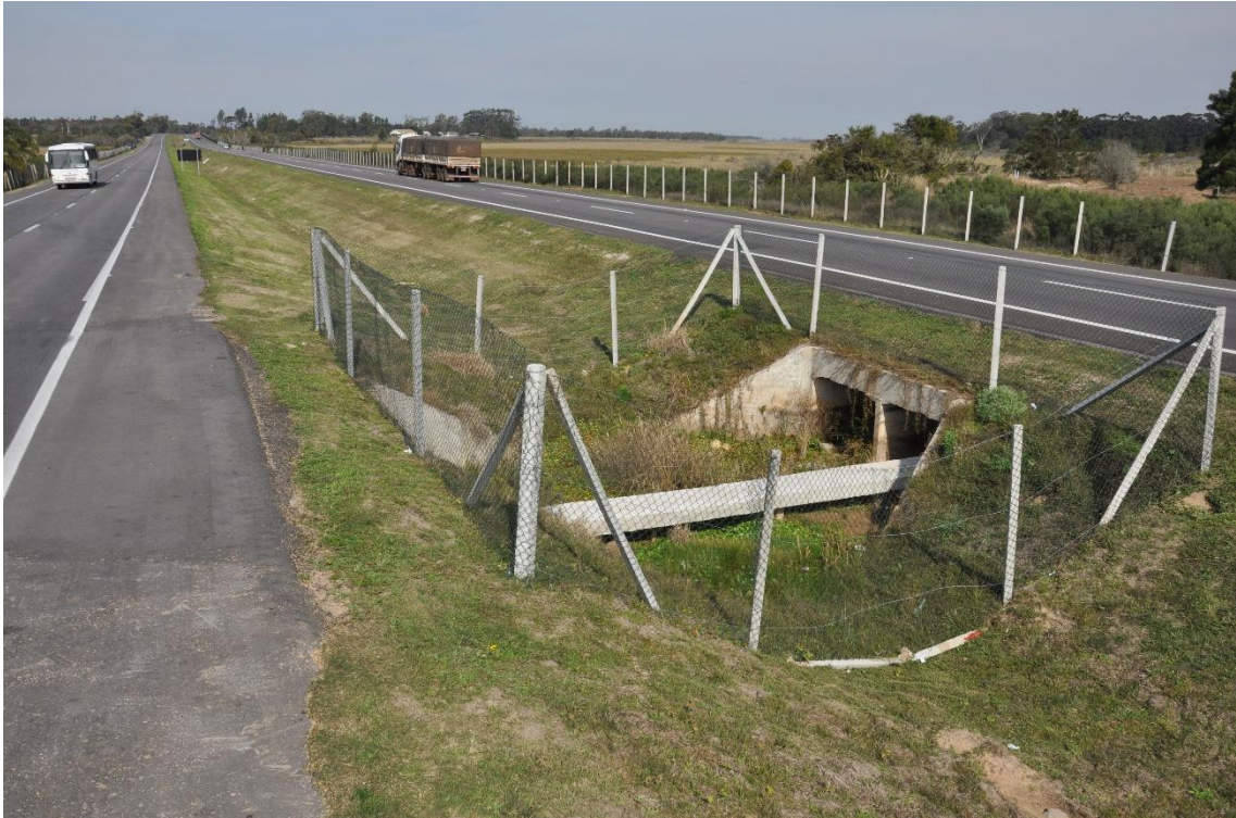
Passagem de fauna mista e telamento da rodovia, na BR-116/392/RS, município de Pelotas.
