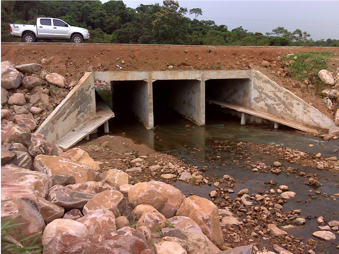
Passagem de fauna úmida, com passagens secas laterais para pequenos animais, na BR-158/MT, no município de Confresa.
