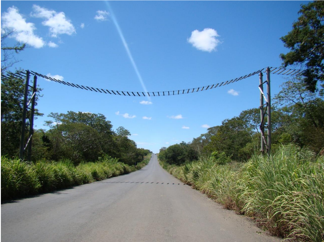
Passagem de fauna aérea para primatas, na BR-135/MG, no município de Manga.
