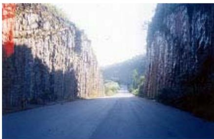
*Taludes de corte da rodovia, km 261,9. Afloramentos de rocha granítica.*
