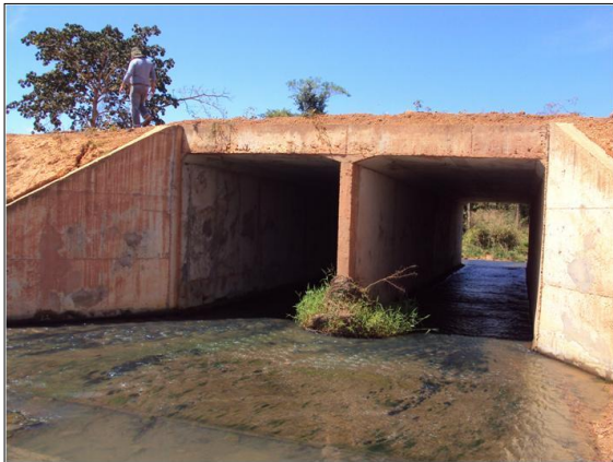
Figura 50 – Galeria dupla a ser adaptada para passagem mista.
