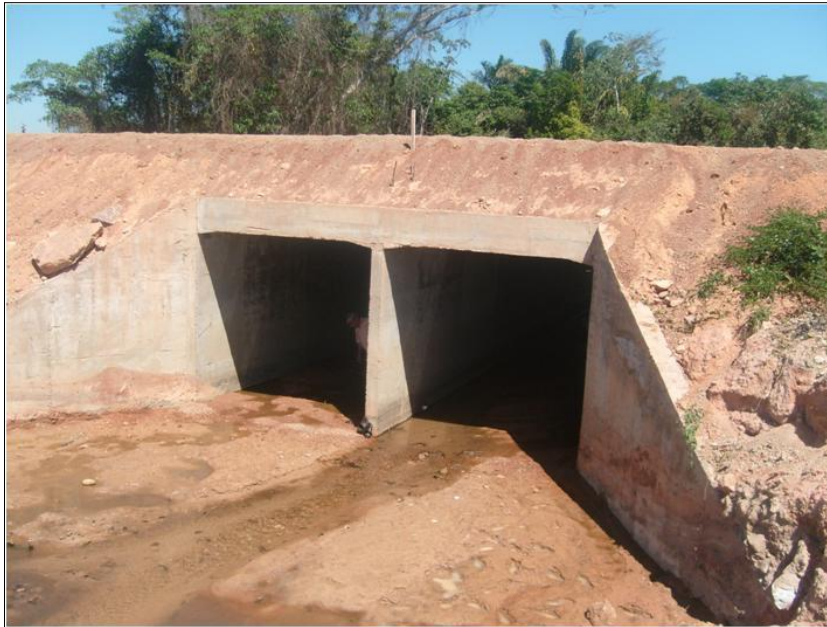
Figura 49 – Galeria dupla a ser adaptada para passagem mista.
