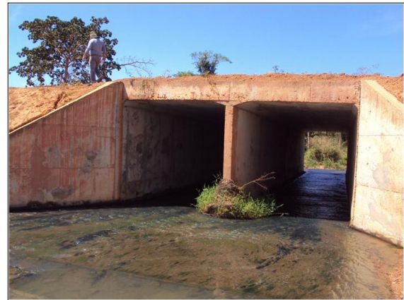
Figura 42 – Interior submerso da galeria dupla construído no curso d'água nº 9, subtrecho 2.
