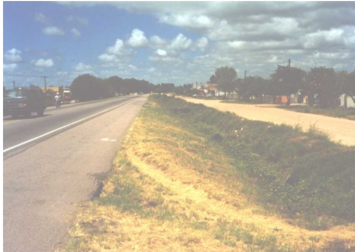
Travessia no Distrito Industrial - BR 116
