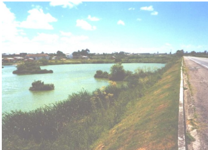
Açude Formado pelo Aterro da Rodovia - BR 392
