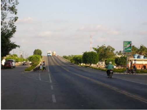
Travessia urbana de Teotônio Vilela, Alagoas
