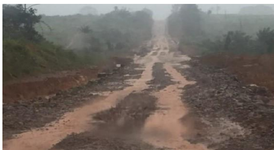
Figura 8 - Exemplo de via rural com trilha de roda. (Fonte: Acervo próprio)
