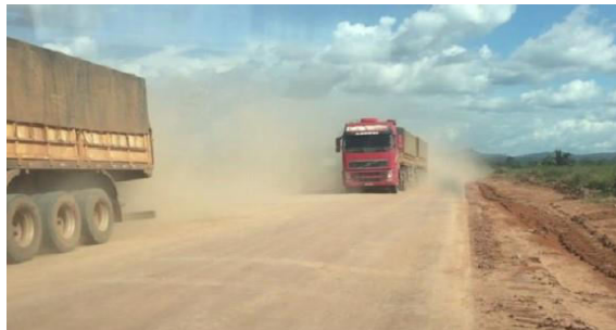
Figura 4 - Exemplo de via rural com severidade alta para excesso de poeira. (Fonte: Acervo próprio)
