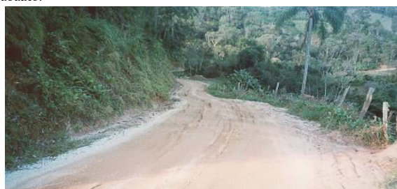
Figura 6 - Exemplo de via rural com severidade média de seção transversal imprópria. (Fonte: Baesso e Gonçalves, 2003)
