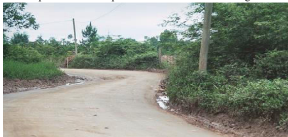
Figura 9 - Exemplo de via rural com severidade baixa de drenagem deficiente. (Fonte: Baesso e Gonçalves, 2003)
