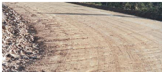
Figura 2 - Exemplo de via rural com severidade baixa para corrugações. (Fonte: Baesso e Gonçalves, 2003)
