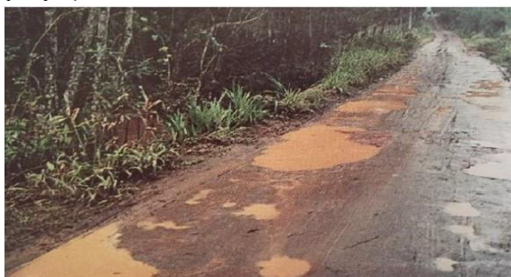
Figura 1 - Exemplo de via rural com buracos no pavimento. (Fonte: Baesso e Gonçalves, 2003)
