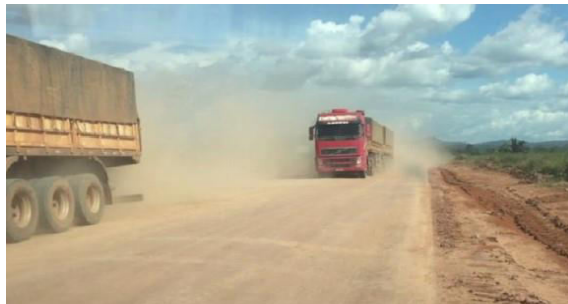
Figura 4 - Exemplo de via rural com severidade alta para excesso de poeira. (Fonte: Acervo próprio)
