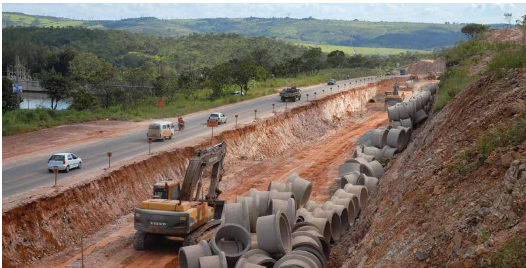
BR- 070/GO/DF - Obras de duplicação na divisa
