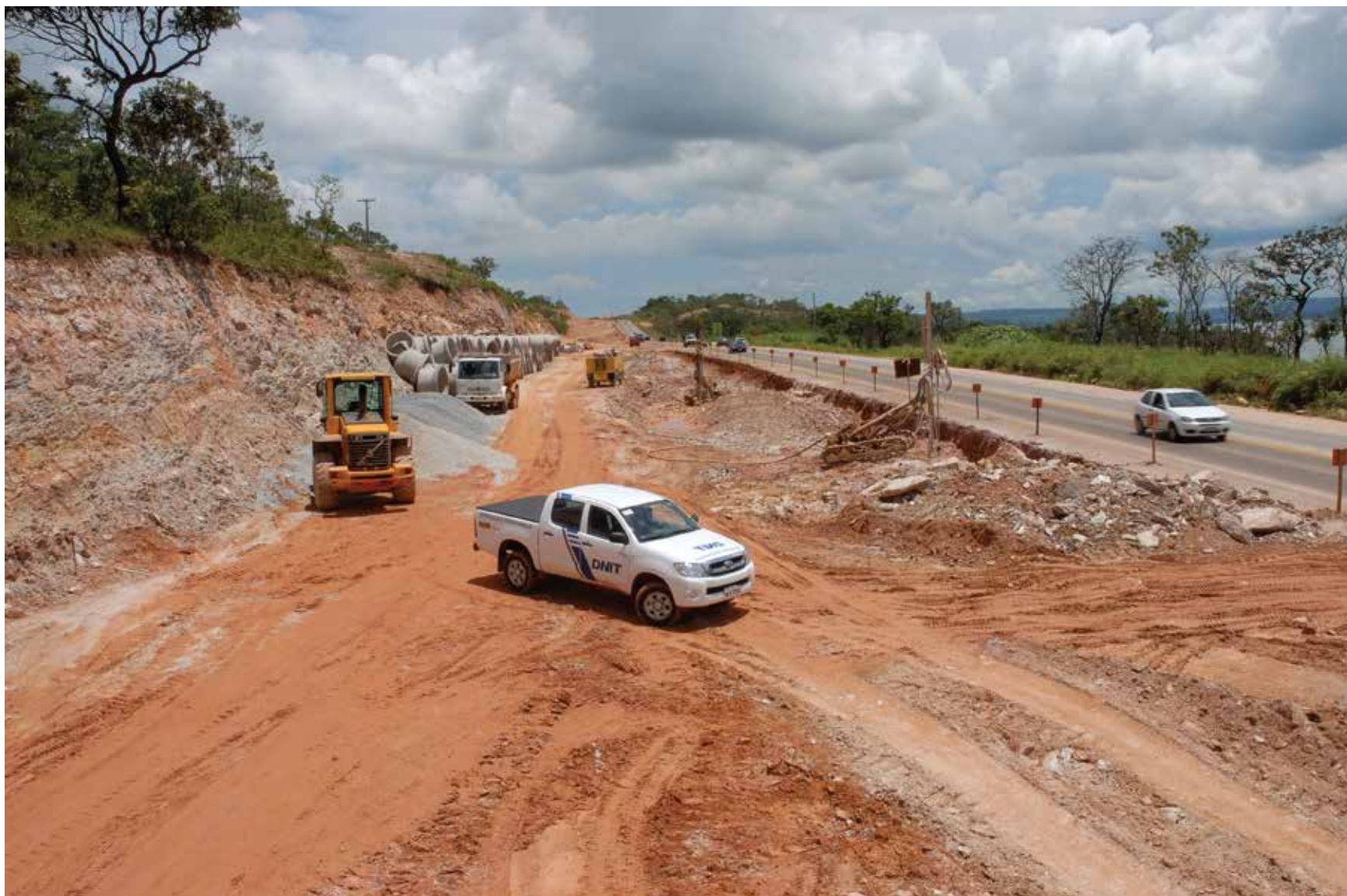
BR- 070/GO - Obras de duplicação em Águas Lindas
