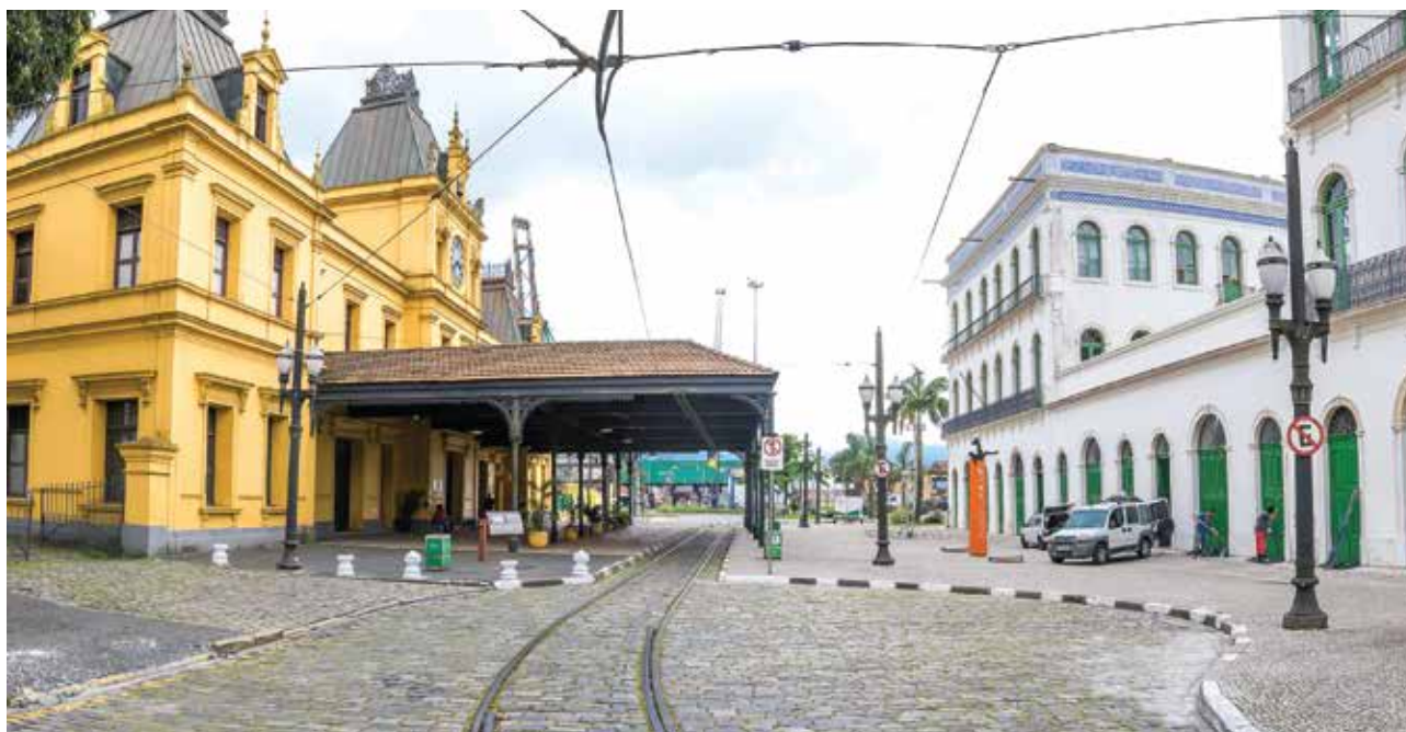
Estação do Valongo/SP
