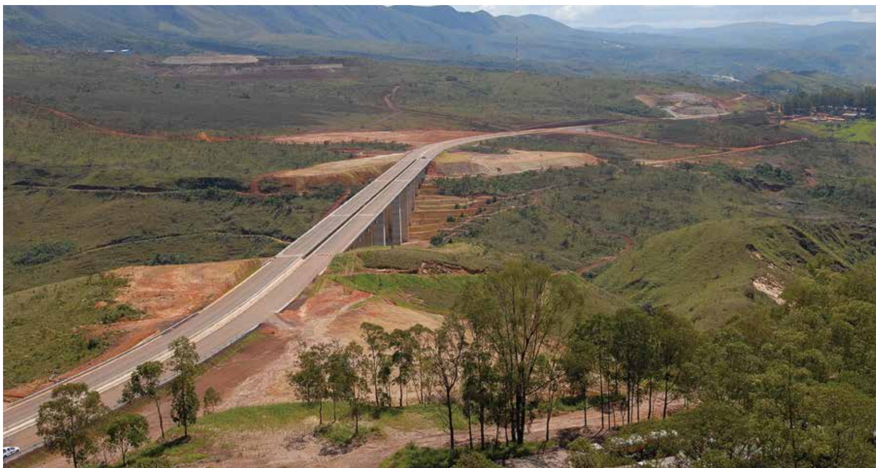
BR-040/MG - Viaduto Vila Rica
