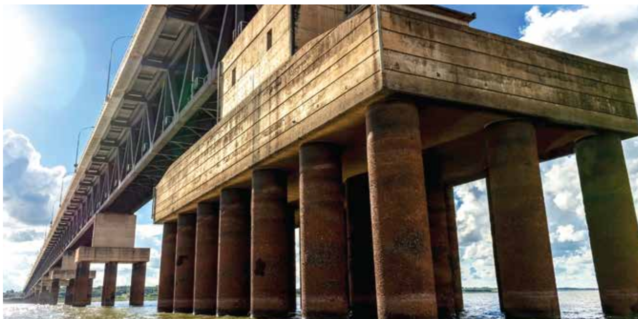
Ponte sobre o Rio Paraná/PR
