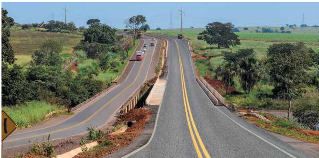
Acima, imagens das obras da ponte sobre o Rio Verdão
