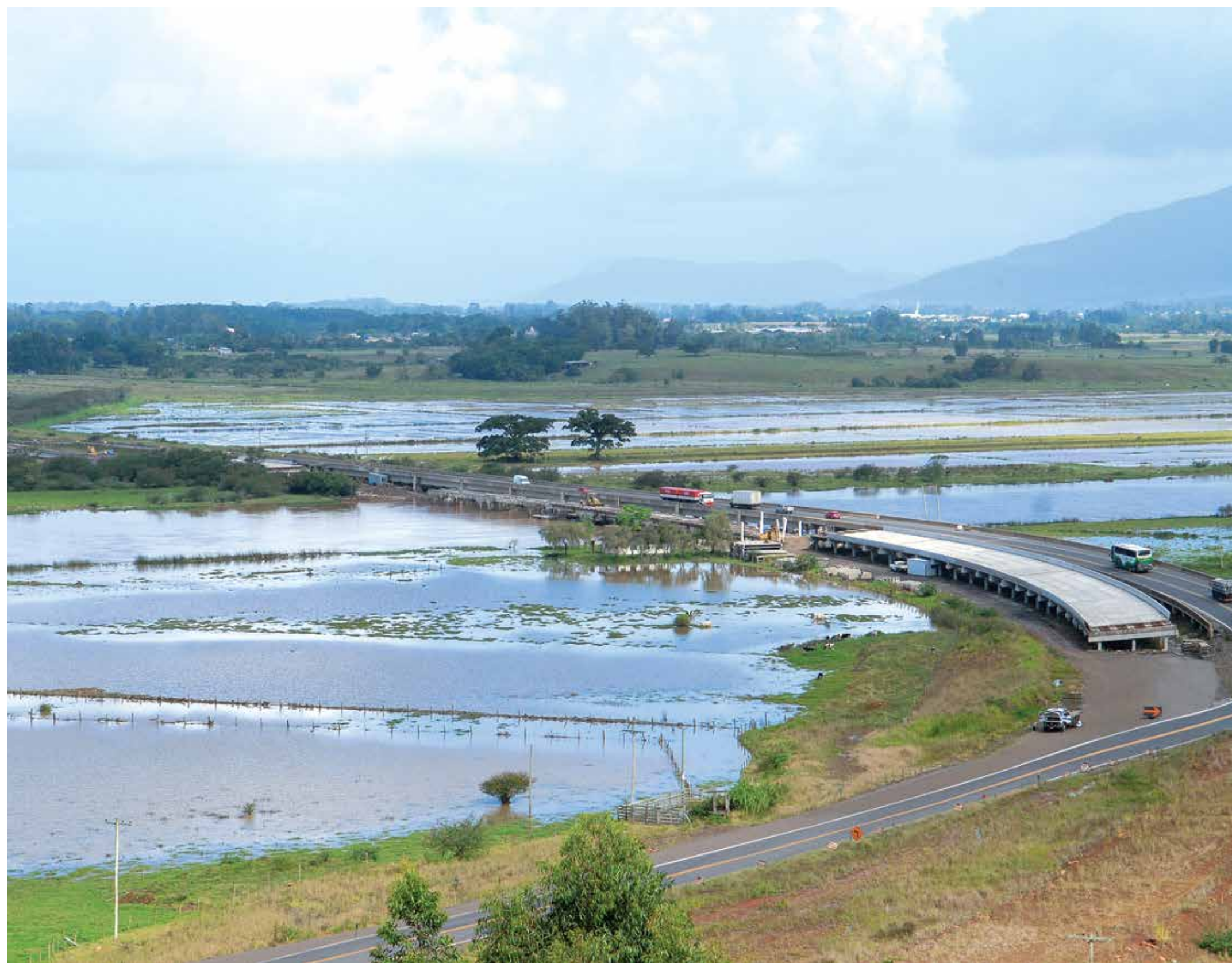
BR-101/RS/SC - Obras na ligação Torres/Osório
