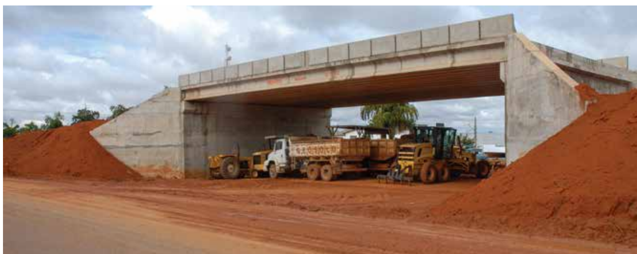
BR-163/MT - Obras na ligação Lucas do Rio Verde-Sorriso
