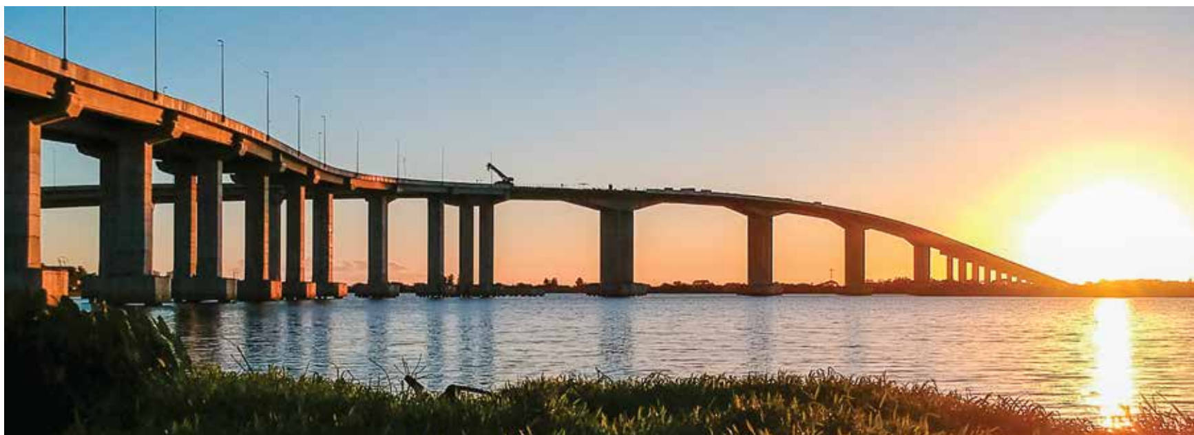
BR-116/RS - Ponte sobre o Rio Guaíba
