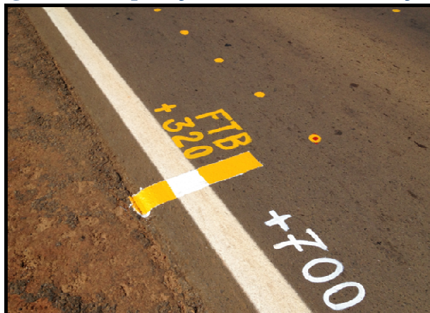
Figura 8 – Preparação da Pista de Calibração
