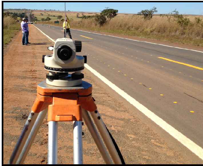
Figura 6 – Preparação da Pista de Calibração
