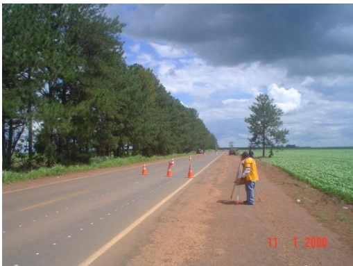
Levantamento com Nível Topográfico
