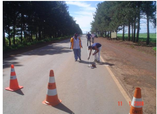
Demarcação do trecho
