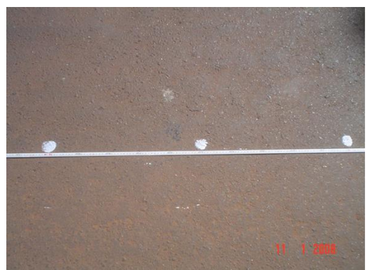
Detalhe do estaqueamento
