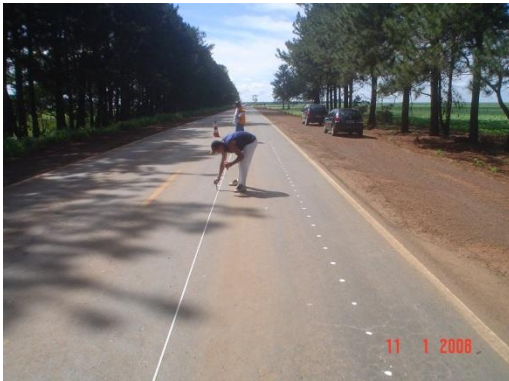
Demarcação do trecho
