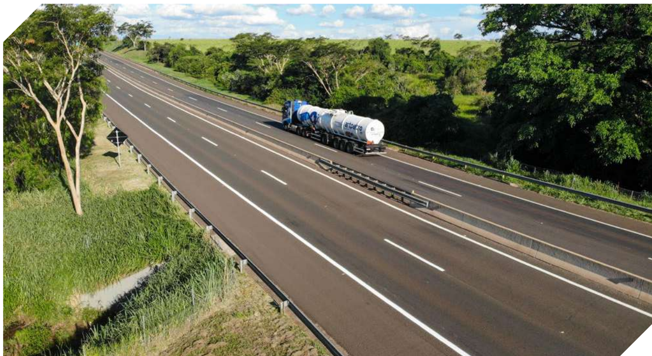
Figura 34. Cercamento associado à passagem inferior de fauna em rodovia no estado de São Paulo. © ViaFAUNA. Foto por Raphael de Oliveira.
