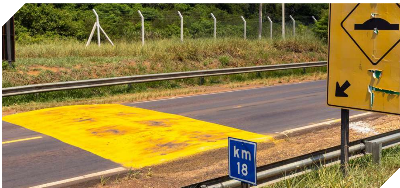
Figura 56. Ondulação transversal em trecho final de cercamento de fauna na rodovia SP-613, dentro do Parque Estadual Morro do Diabo, estado de São Paulo. © ViaFAUNA. Foto por Raphael de Oliveira.
