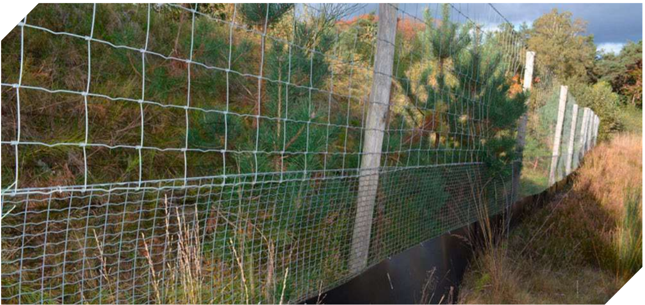
Figura 36. Uso de placa vinilica em porção inferior de cercamento de fauna em rodovia da Holanda. © ViaFAUNA. Foto por Fernanda Abra.
