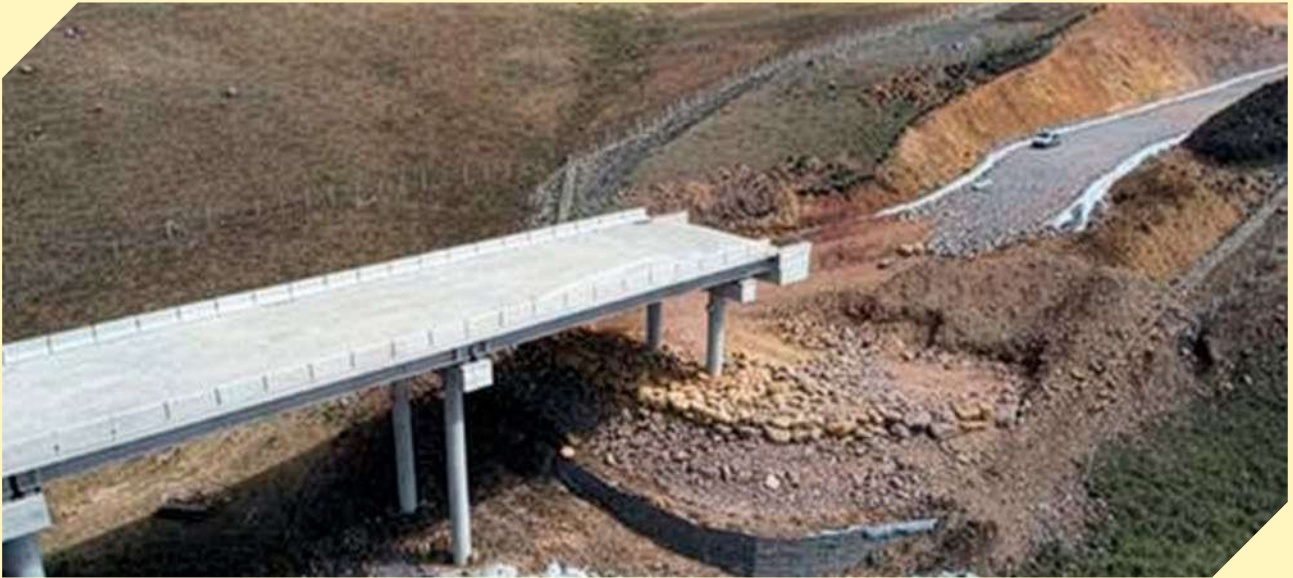
Figura 72. Adaptações em andamento nas cabeceiras de uma das pontes destinadas também à transposição da fauna. Crédito: Gestão Ambiental BR-285/RS/SC – STE S.A.
