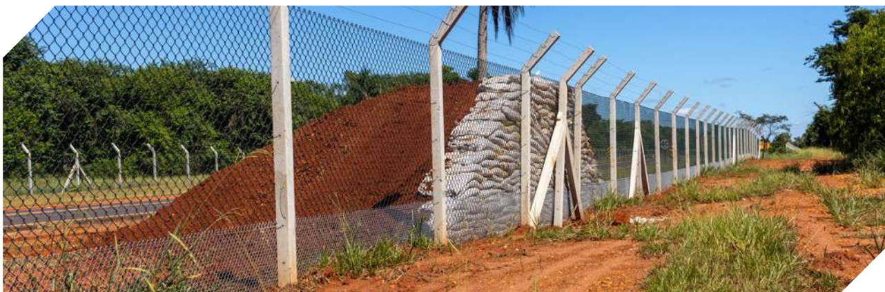
Figura 38. Jump-out em construção em associação a cercamento de fauna na rodovia SP-613, no Parque Estadual Morro do Diabo, estado de São Paulo. © ViaFAUNA. Foto por Raphael de Oliveira.
