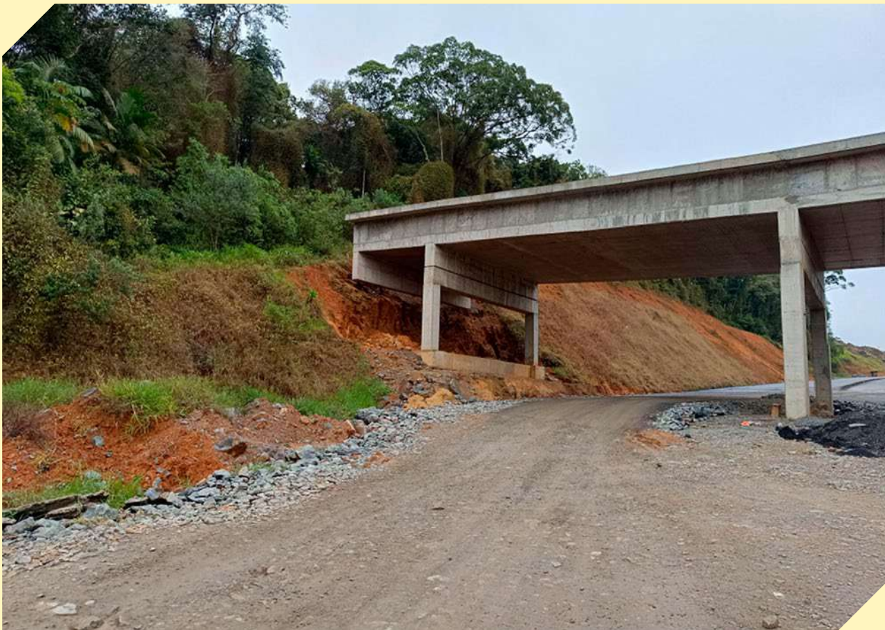
Figura 74. Viaduto vegetado em construção na BR-280/SC.
