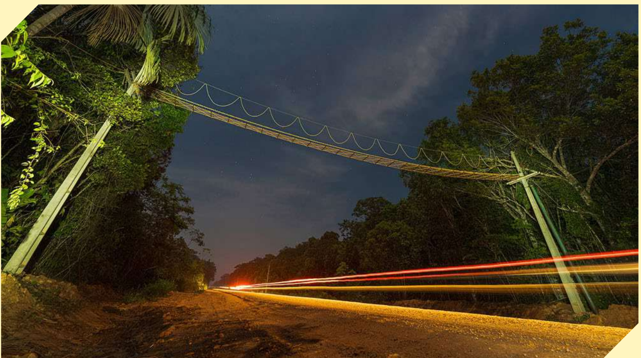
Figura 65. Detalhes do design da ponte de dossel instalada na BR-319. © WCS Brasil. Foto por Marcos Amend.
