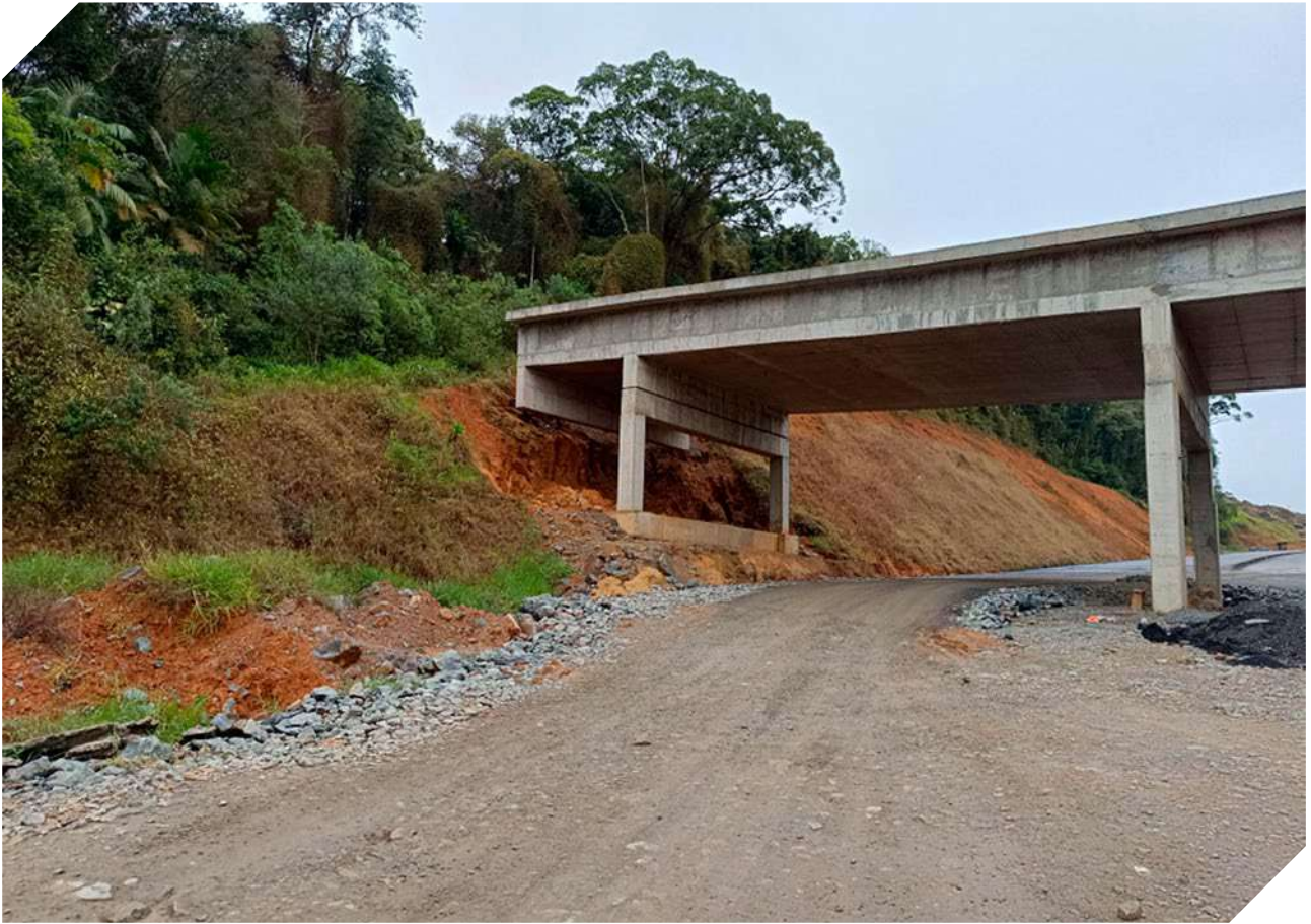
Figura 45. Instalação de Viaduto vegetado na Rodovia Federal BR-280 no contorno viário de Jaraguá do Sul e Guaramirim, em Santa Catarina.
