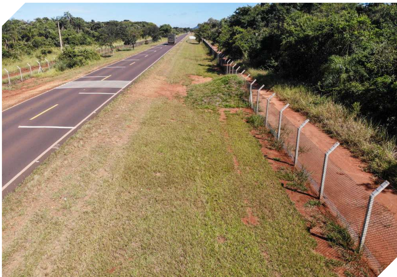
Figura 59. Uso de linha de estímulo à redução de velocidade em complementação a trecho cercado e com passagens inferiores de fauna na rodovia SP-613 dentro do Parque Estadual Morro do Diabo, estado de São Paulo. © ViaFAUNA. Foto por Raphael de Oliveira.
