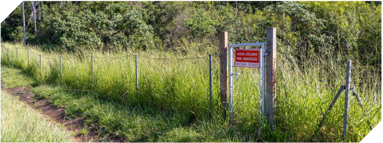
Figura 40. Exemplo de portão de acesso em cercamento de rodovia no estado de São Paulo. © ViaFAUNA. Foto por Raphael de Oliveira.
