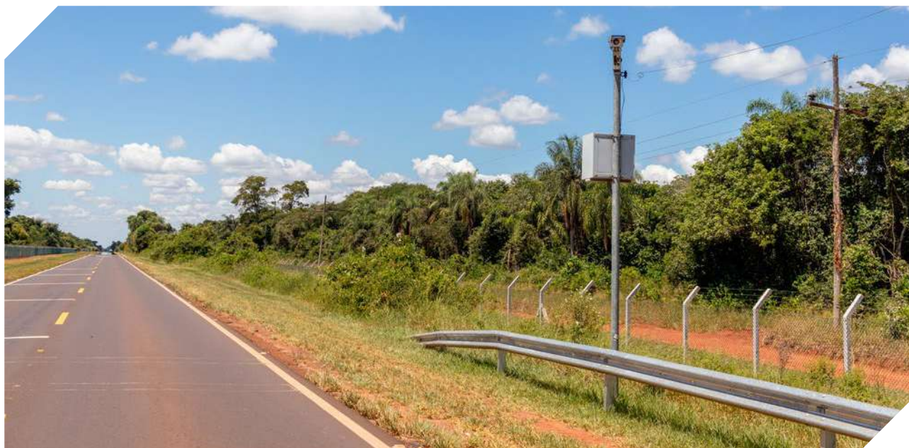
Figura 57. Uso de limitador eletrônico de velocidade em complementação a trecho cercado e com passagens inferiores de fauna na rodovia SP-613, dentro do Parque Estadual Morro do Diabo, estado de São Paulo. © ViaFAUNA. Foto por Raphael de Oliveira.
