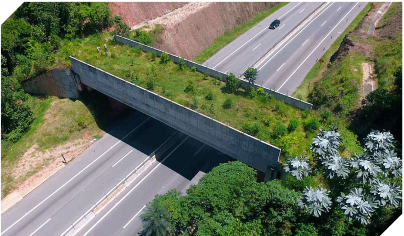
Figura 44. Exemplo de viaduto vegetado construído na SP-099, rodovia dos Tamoios, município de Paraibuna/SP. © ViaFAUNA. Foto por Luiz Antonio Gambá.
