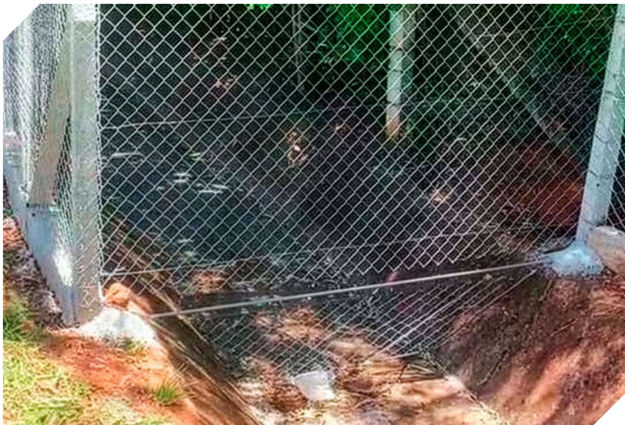
Figura 42. Exemplo de extensão de cercamento em vãos de canaletas de drenagens. © ViaFAUNA. Foto por Luiz Antonio Gambá.
