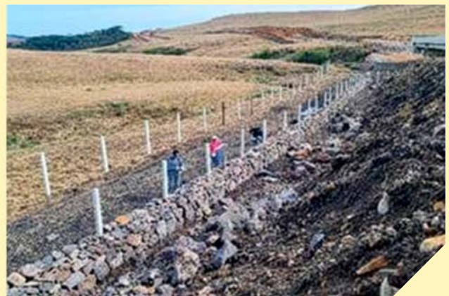
Figura 73. Taipia centenária que representa a identidade cultural da região x implantação de cerca direcionadora com o uso da mesma técnica. Créditos: Gestão Ambiental BR-285/RS/SC – STE S.A.
