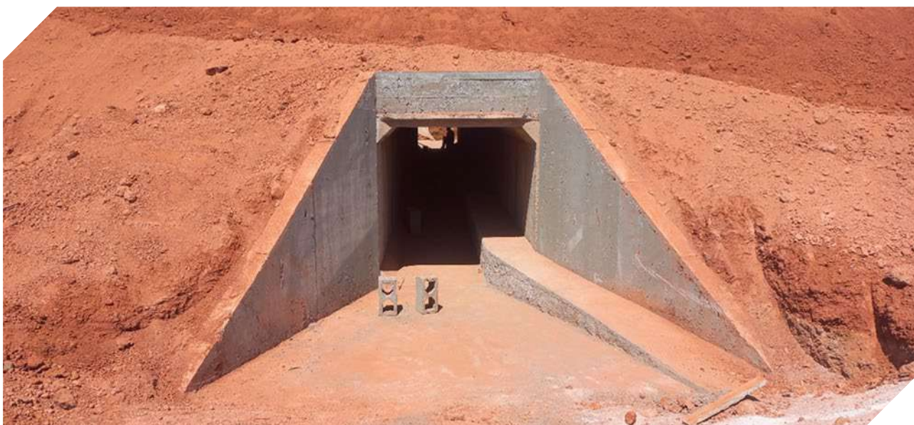
Figura 31. Bueiro simples celular de concreto, em construção, adaptado com mureta lateral para travessia de fauna em ambiente seco e rampa de acesso no emboque. © Gestão Ambiental BR-230/PA, Consórcio STE/ProGaia e SRE/PA.
