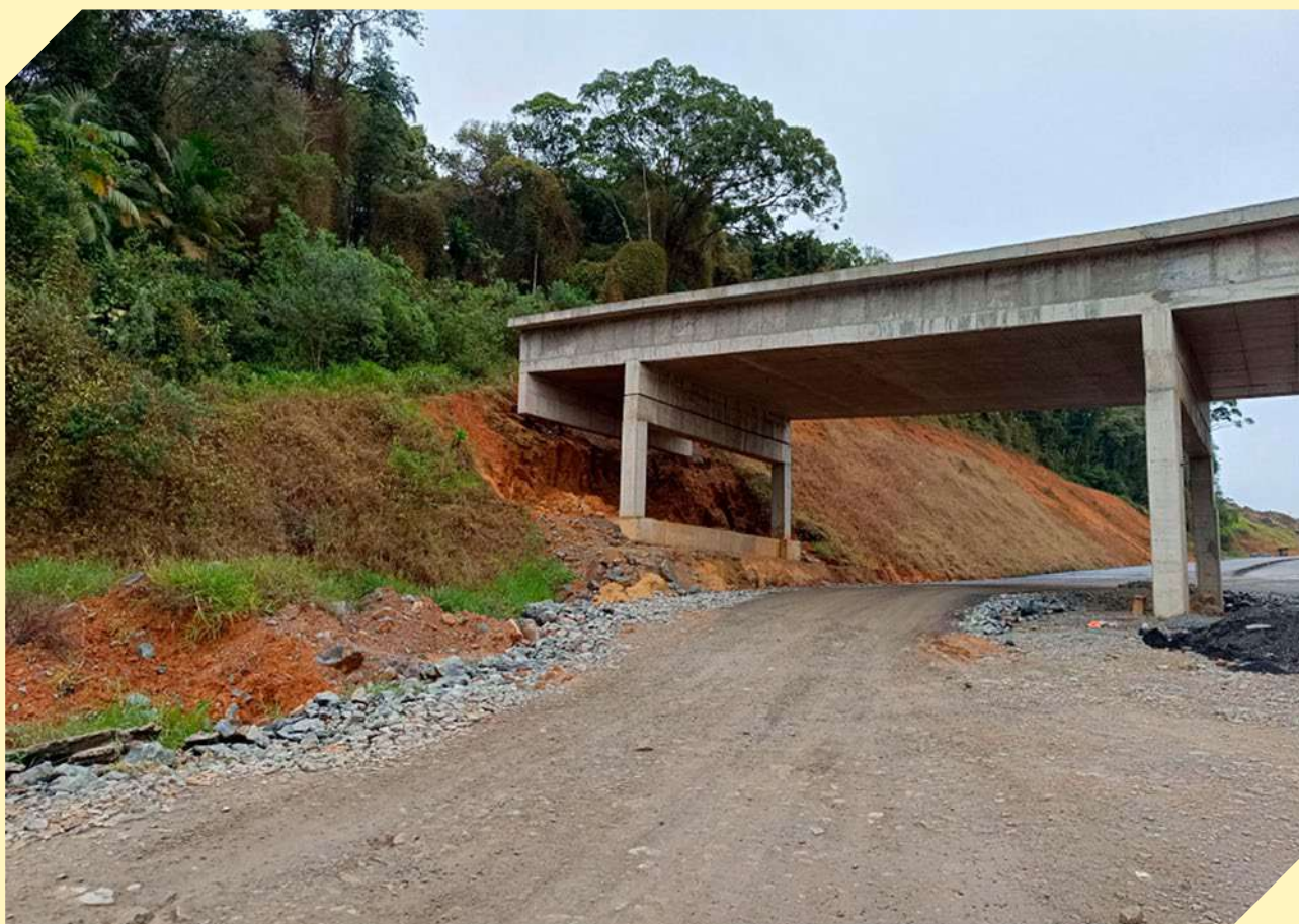
Figura 74. Viaduto vegetado em construção na BR-280/SC.
