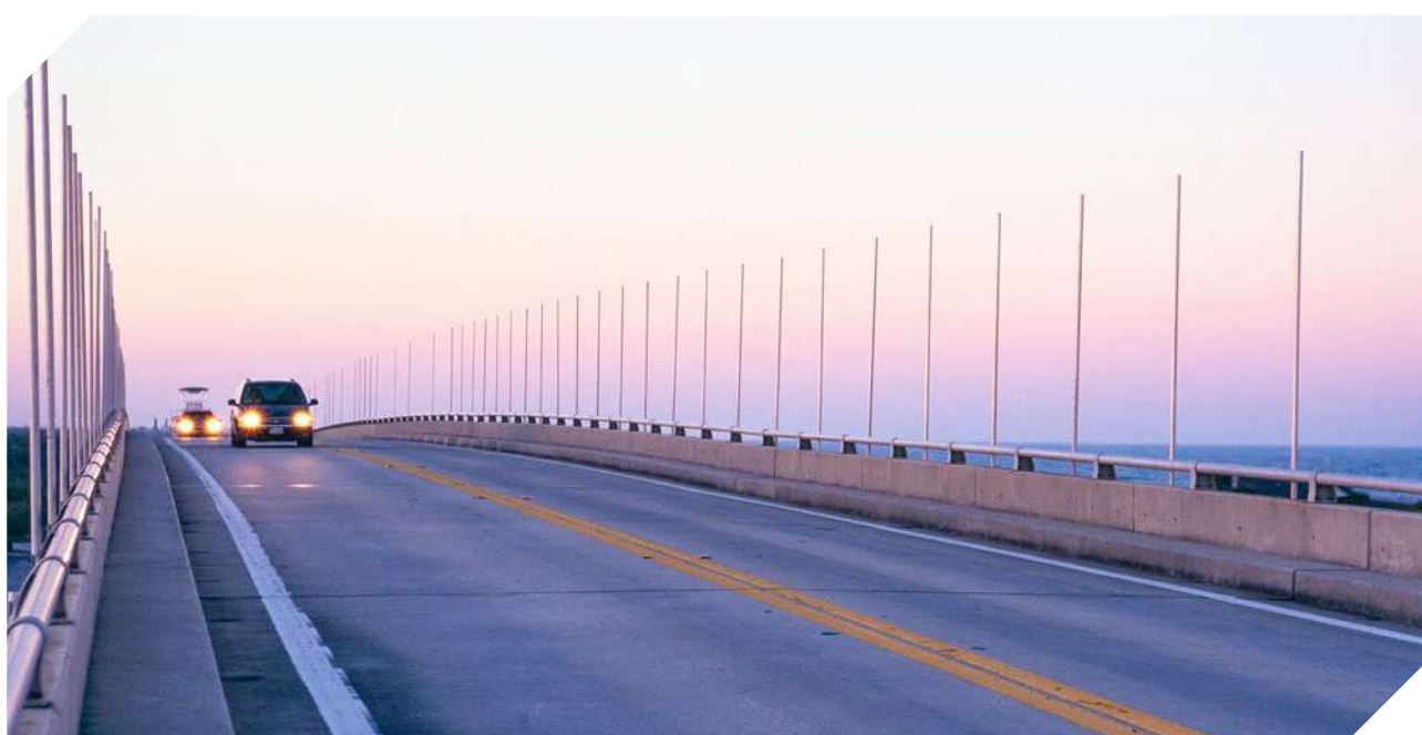
Figura 51. Postes de metal presos a uma ponte para reduzir colisões entre pássaros e veículos, fazendo com que os pássaros voem mais alto, State Road A-1A, Sebastian Inlet State Park, Florida . © Marcel Huijser.
