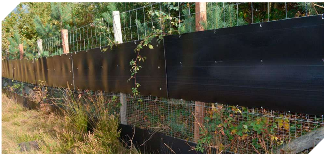
Figura 37. Uso de placa vinilica na porção inferior e intermediária de cercamento de fauna em rodovia da Holanda. © ViaFAUNA. Foto por Fernanda Abra.
