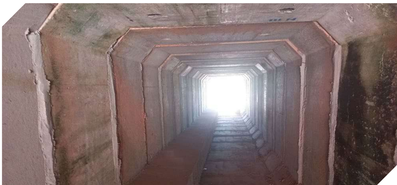
Figura 30. Bueiro simples celular de concreto adaptado com mureta lateral para travessia de fauna em ambiente seco. © Gestão Ambiental BR-230/PA, Consórcio STE/ProGaia e SRE/PA.
