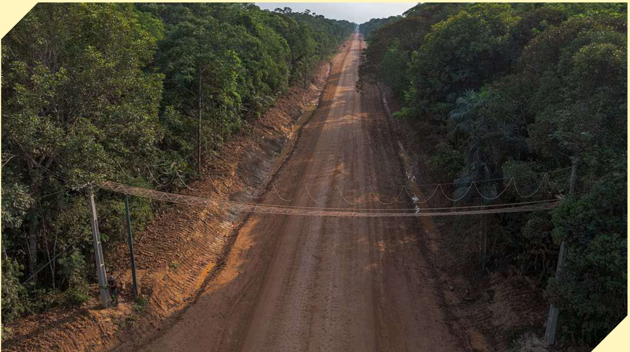
Figura 64. Trecho do meio da BR-319 sem pavimentação e a ponte de dossel instalada. © WCS Brasil. Foto por Marcos Amend.
