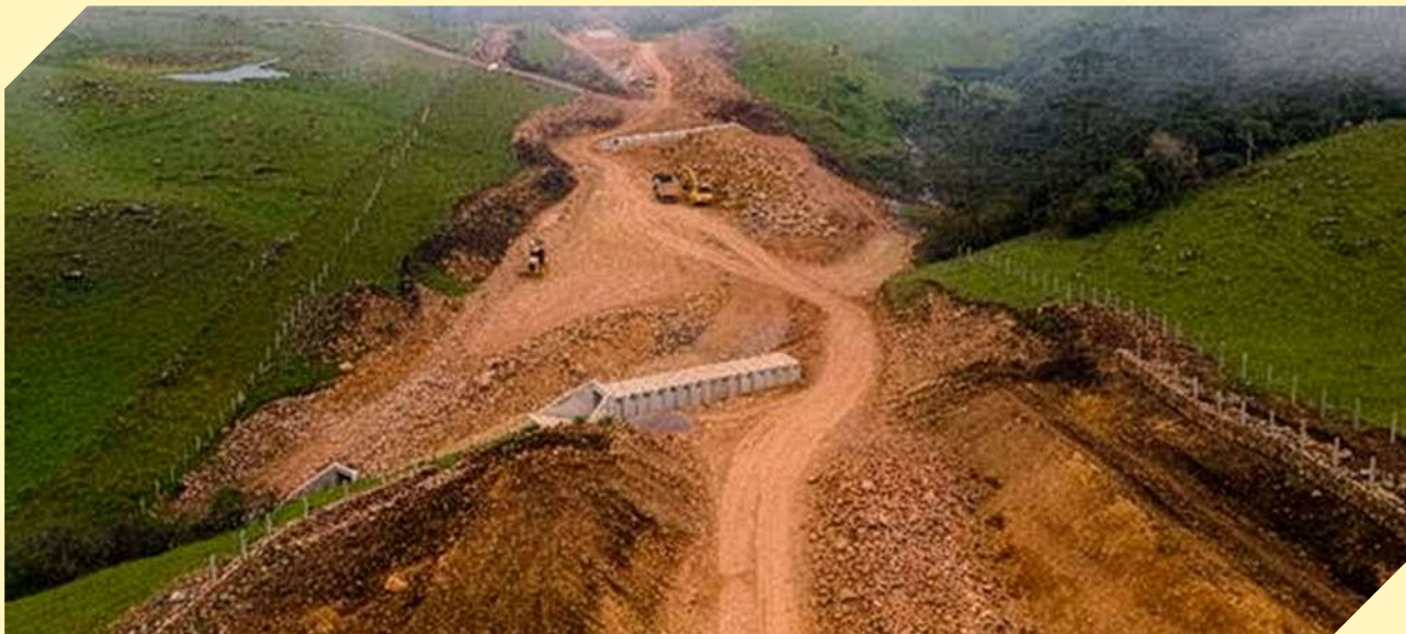
Figura 70. Imagem aérea das estruturas onde foram executadas adaptações na localização e extensão. Crédito: Gestão Ambiental BR-285/RS/SC – STE S.A.
