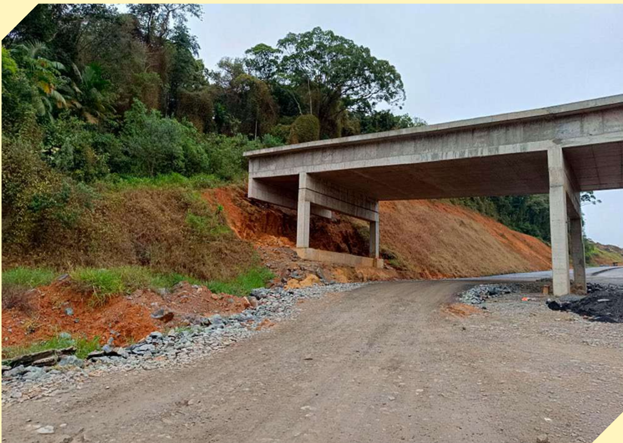
Figura 74. Viaduto vegetado em construção na BR-280/SC.
