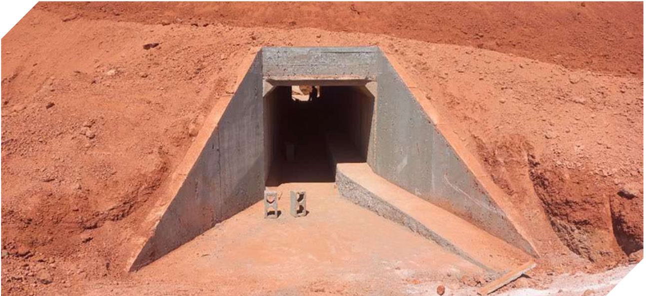
Figura 31. Bueiro simples celular de concreto, em construção, adaptado com mureta lateral para travessia de fauna em ambiente seco e rampa de acesso no emboque. © Gestão Ambiental BR-230/PA, Consórcio STE/ProGaia e SRE/PA.
