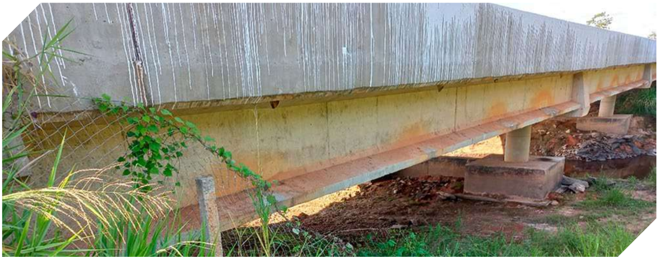
Figura 32. Ponte sobre rio com passagem seca e com cercamento de fauna na rodovia BR-230/PA. © Gestão Ambiental BR-230/PA, Consórcio STE/ProGaia e SRE/PA.
