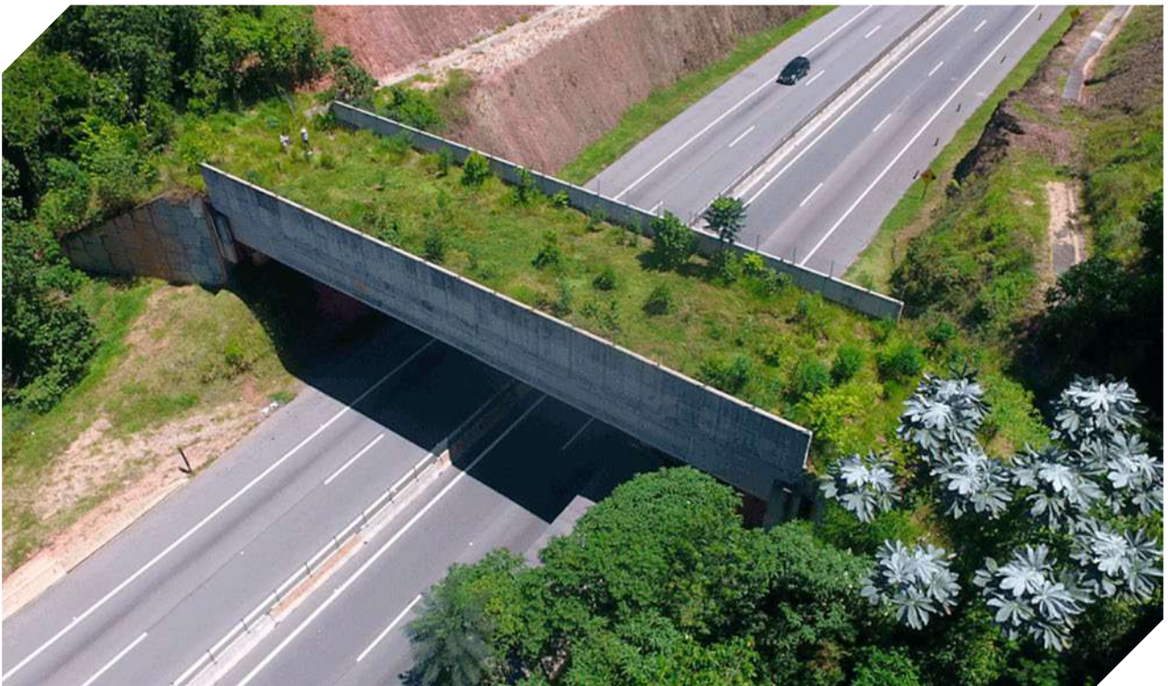
Figura 44. Exemplo de viaduto vegetado construído na SP-099, rodovia dos Tamoios, município de Paraibuna/SP. © ViaFAUNA. Foto por Luiz Antonio Gambá.
