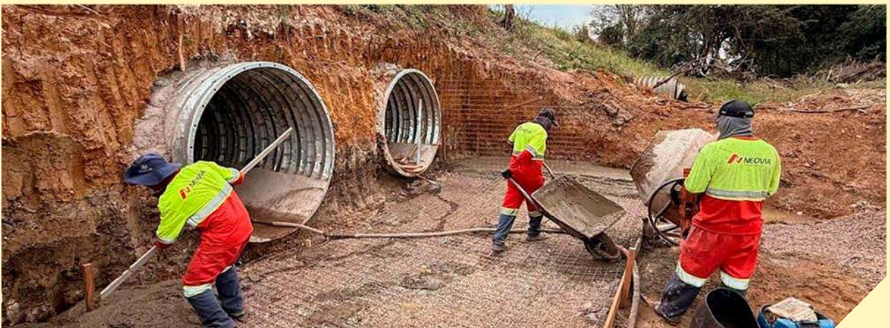
Figura 66. Correção de desnível de emboque com rachão em nova passagem inferior da BR-262/MS como medida de adequação para acesso da fauna silvestre; e obras em andamento para instalação de duas passagens inferiores de fauna. ©ViaFAUNA.
