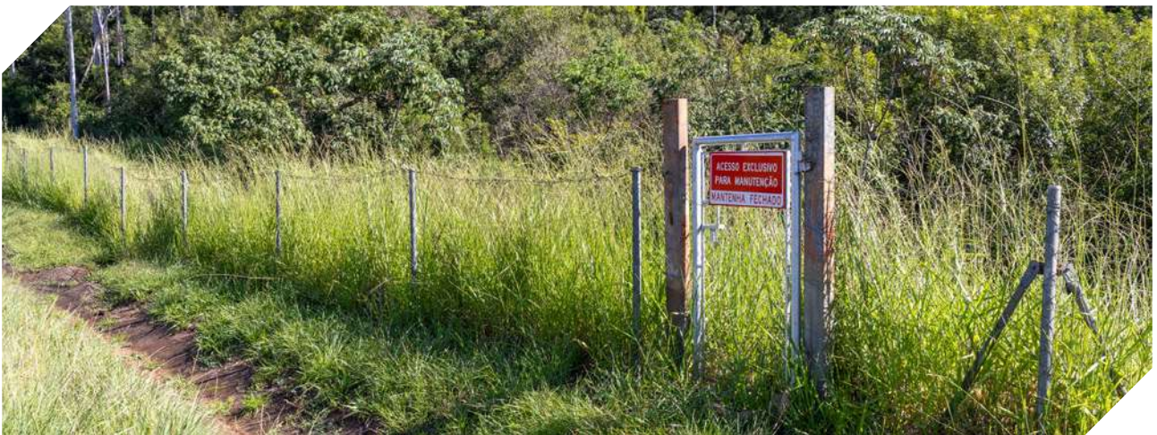
Figura 40. Exemplo de portão de acesso em cercamento de rodovia no estado de São Paulo. © ViaFAUNA. Foto por Raphael de Oliveira.
