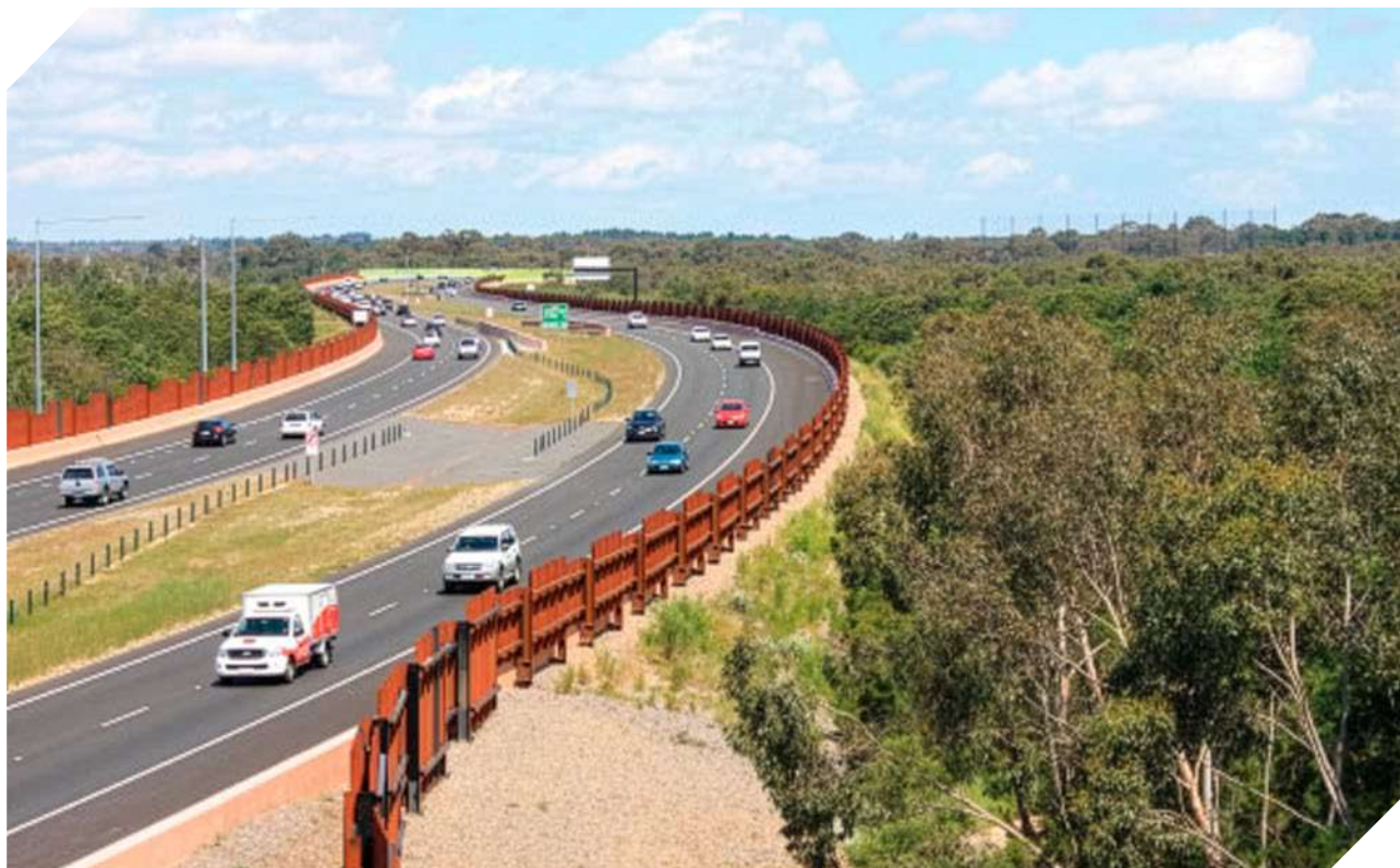
Figura 49. Defletores de voo compostos por placas, instalados em trecho de aterro. © Rodney van der Ree 73 .
