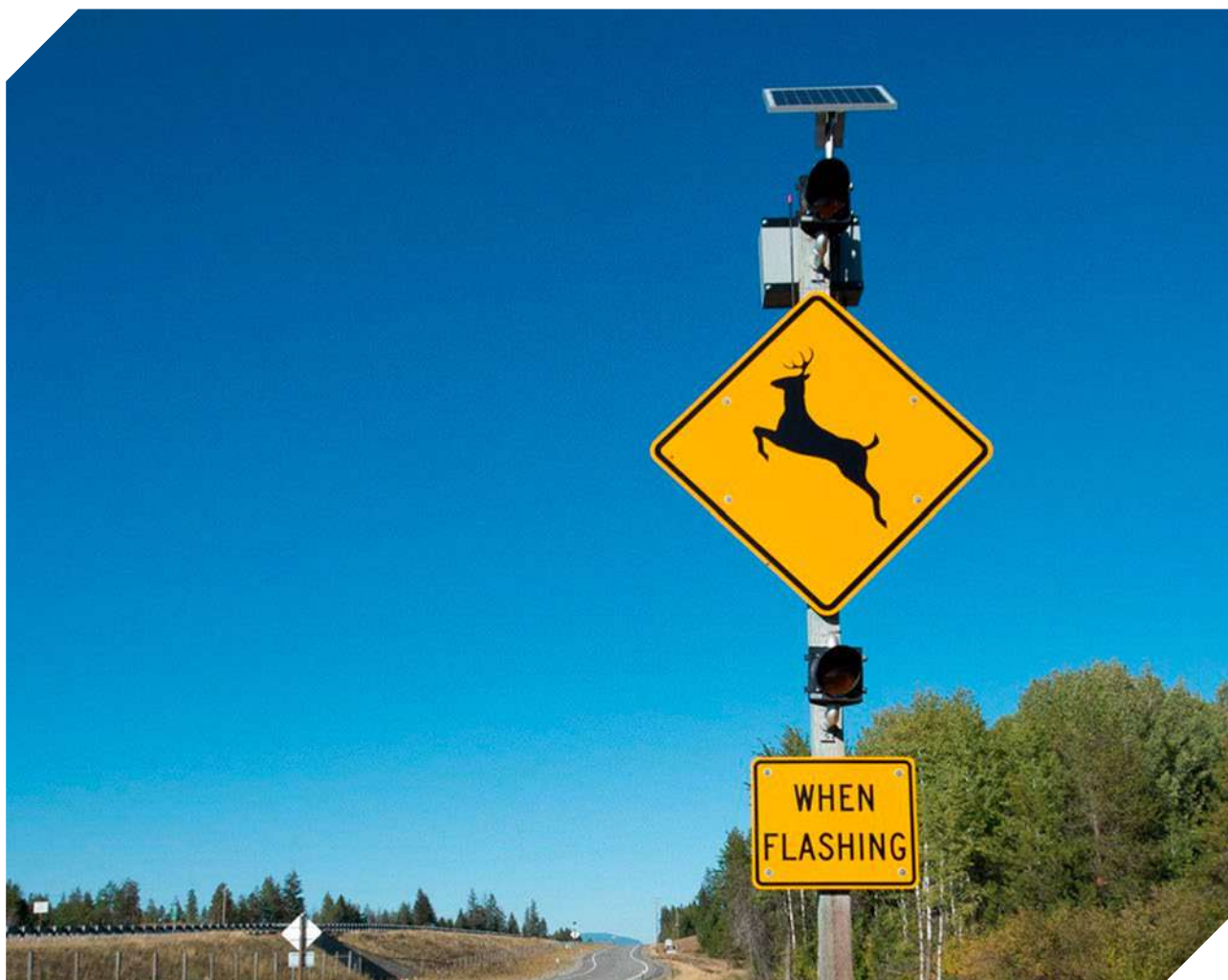
Figura 58. Sistema de Detecção Animal na rodovia 95 em Idaho, Estados Unidos. © Marcel Huijser.
