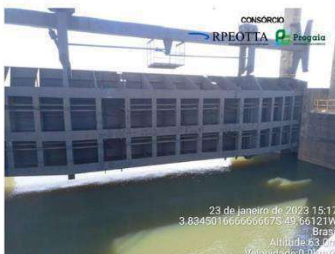
Figura 19 – Posicionamento do corte de fluxo (Eclusa de Tucuruí - Eclusa 1)
