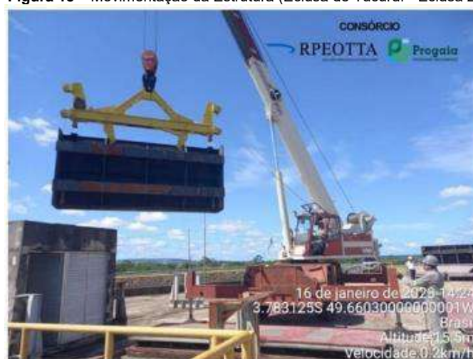
Figura 18 – Movimentação da Estrutura (Eclusa de Tucuruí - Eclusa 2)
