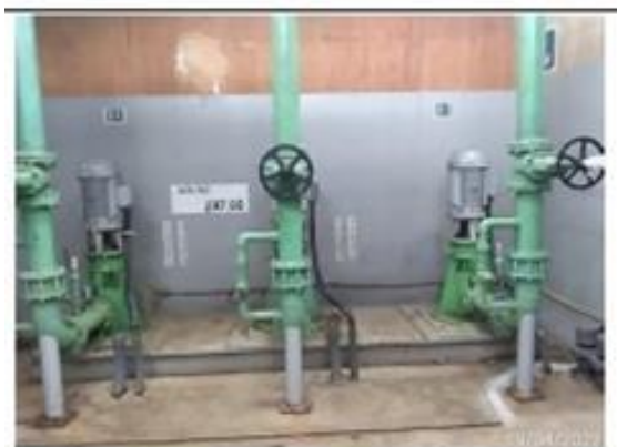
e) Bombas de drenagem operacionais (Eclusa Três Irmãos)
