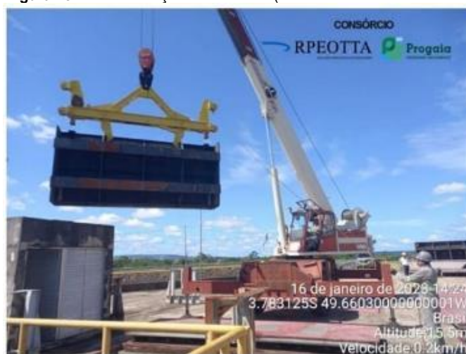
Figura 18 – Movimentação da Estrutura (Eclusa de Tucuruí - Eclusa 2)
