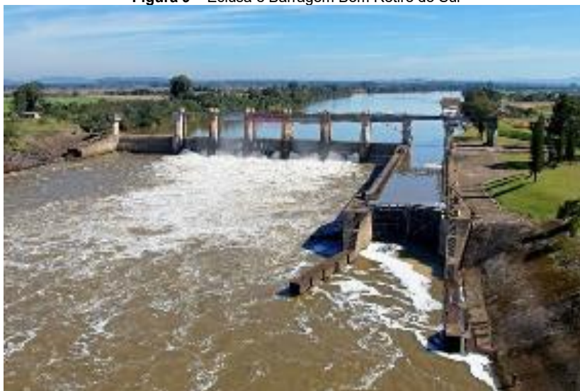
Figura 9 – Eclusa e Barragem Bom Retiro do Sul
