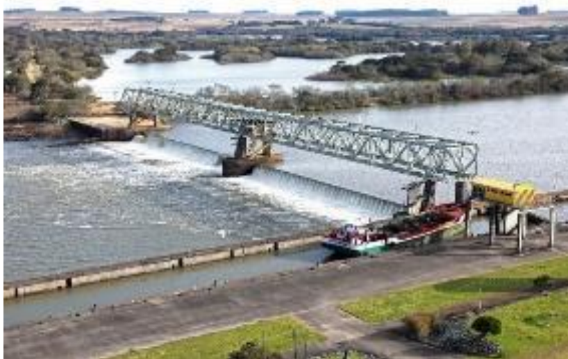
Figura 6 – Eclusa e Barragem de Amarópolis
