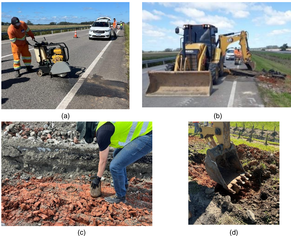
Figura 4 – Abertura da trincheira: (a) Corte no revestimento asfáltico; (b) Retroescavadeira retirando as camadas superiores (PAV); (c) Posicionamento dos cilindros metálicos; (d) Concha da retroescavadeira na cravação dos cilindros no subleito
