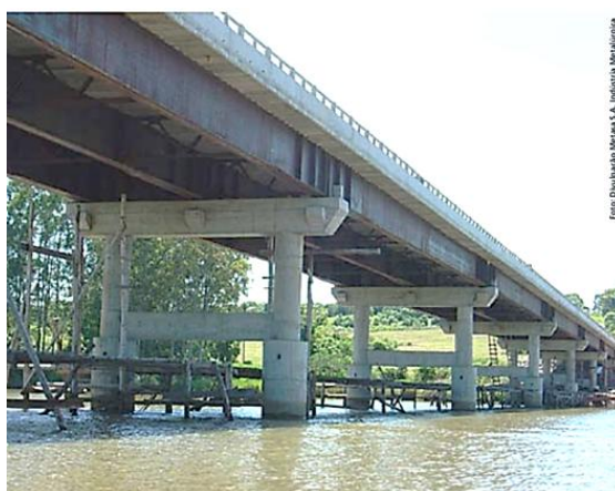
Figura 1.2 – Ponte com Tabuleiro em longarinas mistas de aço e concreto. Ponte sobre a Barragem Maia Filho
