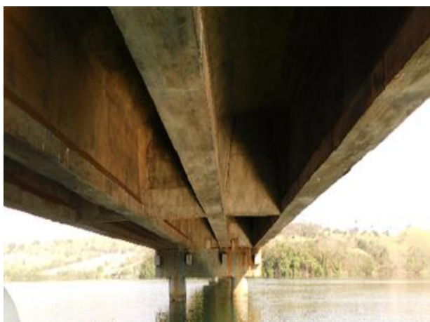
Figura 1.1 – Ponte com longarinas pré-moldadas sobre o rio Araguaí
