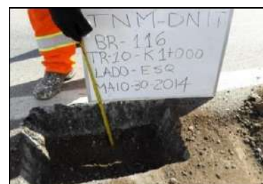
(d) Sondagem realizada
