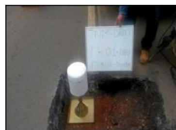
(d) Sondagem realizada
