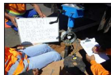
(d) Sondagem realizada
