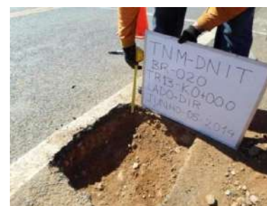
(d) Sondagem realizada
