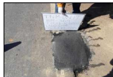
(d) Sondagem realizada
