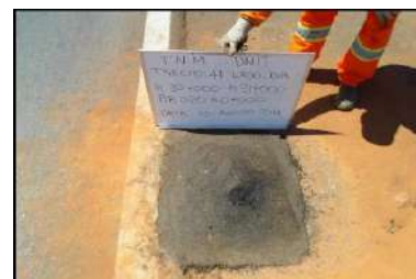
(d) Sondagem realizada
