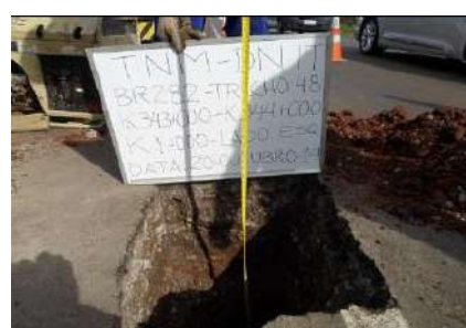
(b) Poço de sondagem da UA48
