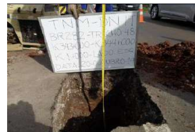
(d) Sondagem realizada
