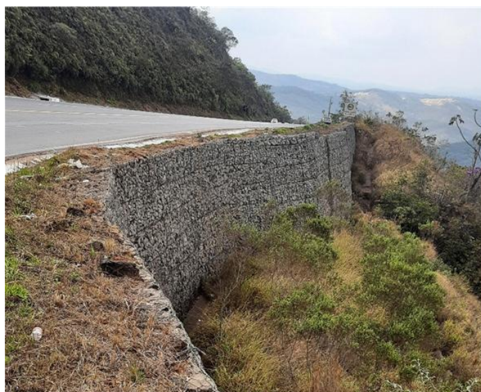
Figura 41 – Muro de gabião BR-356/MG
