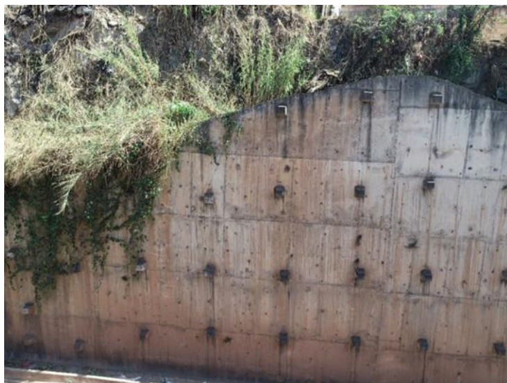
Figura 40 – Cortina atirantada na BR-356/MG
