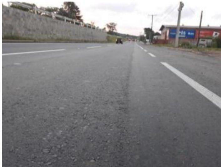
Figura 3 – Emenda construtiva no trecho ID 4.2
