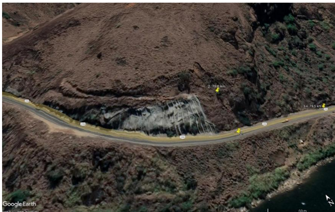
Figura AP 25 – Estrutura de contenção próxima ao Km 79 da BR-259/ES
