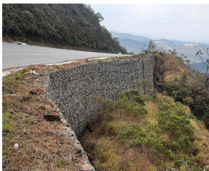
Figura 41 – Muro de gabião BR-356/MG
