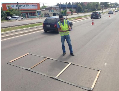
Figura 4 – Execução do levantamento dos defeitos (Fonte: Bueno, 2019)
