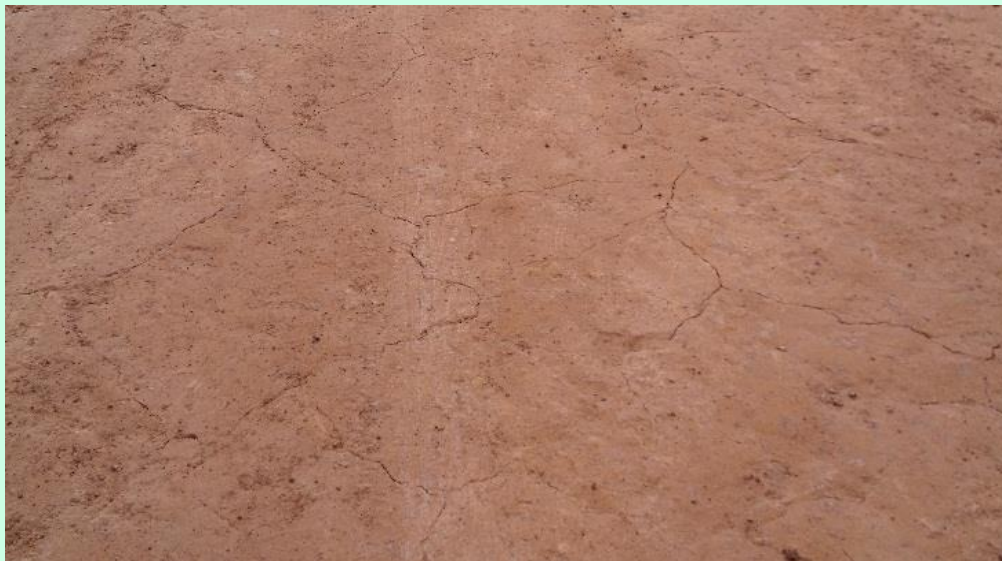
Trincas de retração
