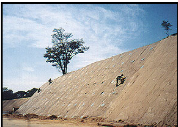
Foto 9 - Após a recuperação da erosão, é aplicada a Tela Fibrax® 400BF, e a malha metálica de alta resistência, ancorando-a nos chumbadores com uma placa metálica
