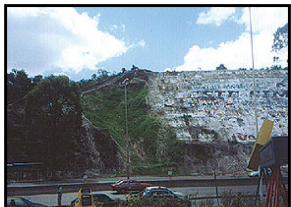
Foto 6 - Mesmo local após a execução da técnica, mostrando a eficiência e melhoria do visual, além dos aspectos ambientais, como infiltração da água, atenuação da radiação e redução da temperatura
