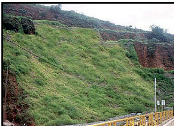
Foto 3 - Mesmo local, três meses após a recuperação e proteção do talude, já totalmente revegetado e isento de focos erosivos
