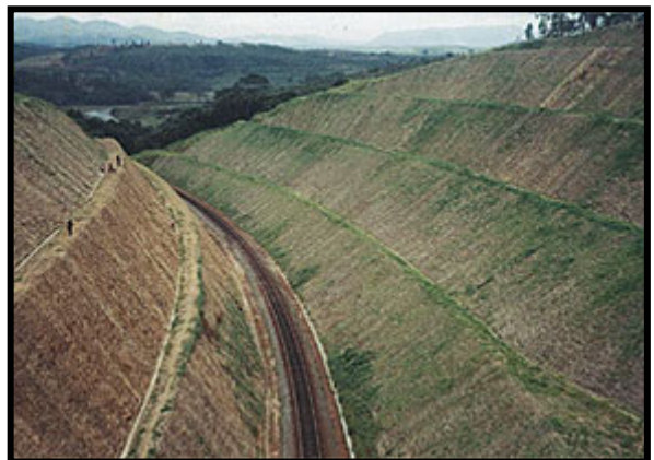
Foto 5 - Serviços de recuperação já adiantados, com drenagem superficial e profunda executada, recuperação das erosões e aplicação de biomanta antierosiva
