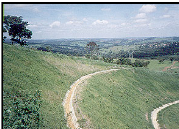
Foto 12 - Resultado do trabalho, mostrando toda a área protegida, o estabelecimento da vegetação e a ausência de sulcos e focos erosivos.
