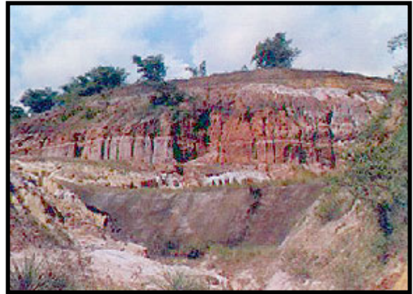
Foto 07 - Vista geral das erosões, as quais serão recuperadas com uso das Técnicas de Bioengenharia e produtos biodegradáveis
