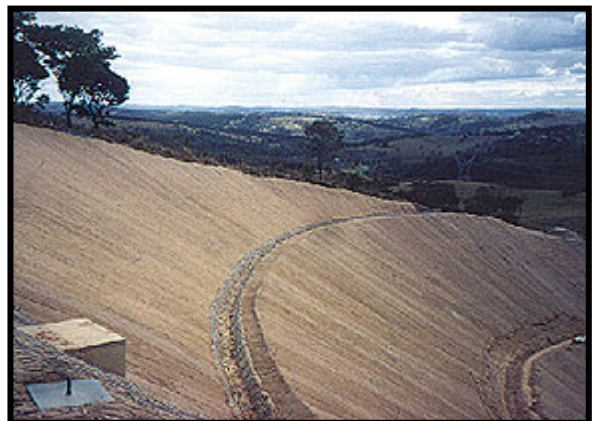
Foto 11 - A proteção dos taludes foi feita com biomanta antierosiva de fibra de coco bidimensional (Tela Fibrax® 400BF), protegendo imediatamente a área até o estabelecimento total da vegetação
