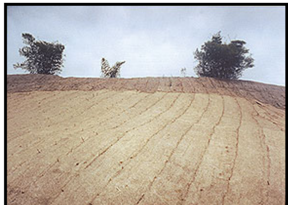
Foto 09 - Mesmo local imediatamente após a execução dos serviços, mostrando o aspecto visual, a proteção total dos taludes cuja superfície será coberta pela vegetação posteriormente
