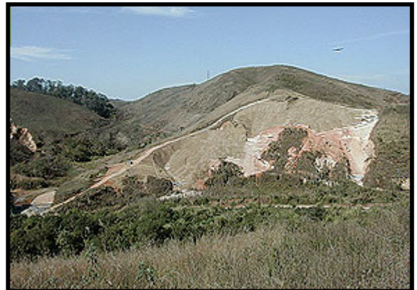
Foto 15 - Serviços de recuperação já adiantados, com drenagem superficial e profunda executada, recuperação das erosões e aplicação de biomanta antierosiva
