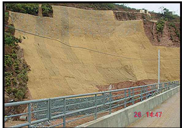
Foto 2 - Mesmo talude, já recuperado e protegido com a técnica de solo grampeado verde e biomantas antierosivas
