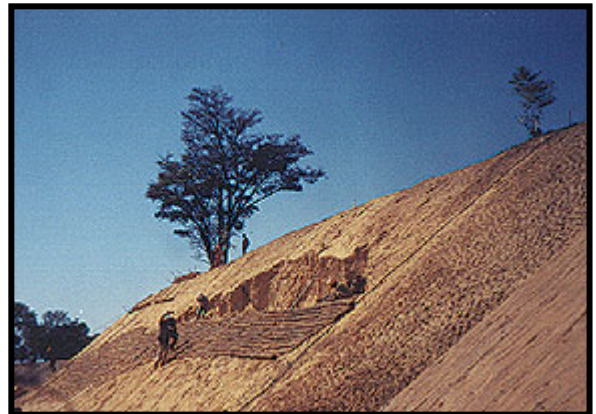
Foto 8 - Após a aplicação dos chumbadores no talude, a erosão está sendo recuperada e preenchida com uso de rip-rap de retentores de sedimentos tipo Bermalonga® D20
