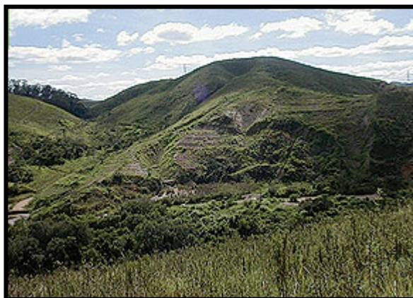
Foto 16 - Mesmo local após três meses da execução dos serviços, vê-se a eficiência do método, nenhum foco erosivo e a área completamente revegetada
