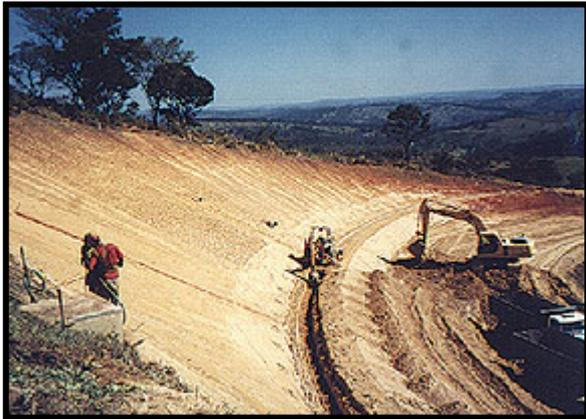
**Foto 10 - Taludes e drenagem em construção, sendo o material do talude de grande suscetibilidade à erosão, por isso deverá ser protegido com segurança e rapidez**
