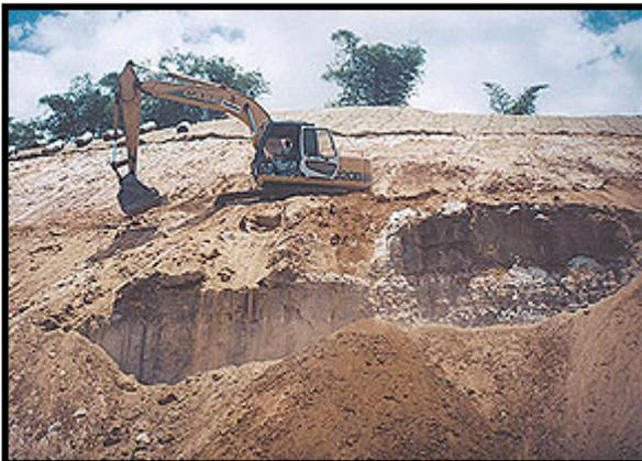
**Foto 08 - Serviços de recuperação já adiantados, com drenagem superficial e profunda executada, recuperação das erosões e aplicação de biomanta antierosiva**
