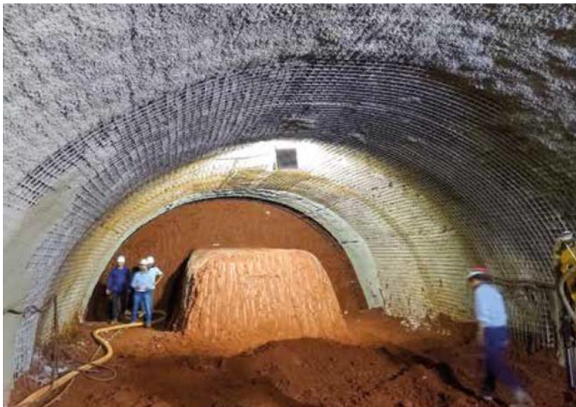
Figura 4.40 Núcleo para estabilização da frente de escavação
