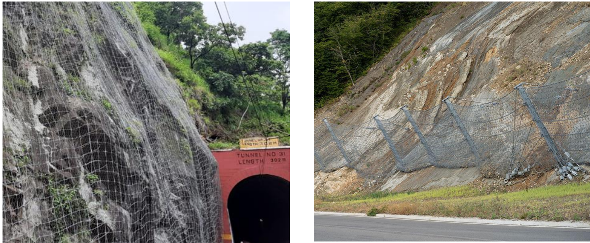
Figura 4.21 Proteção/estabilização de taludes rochosos com telas de alta resistência
