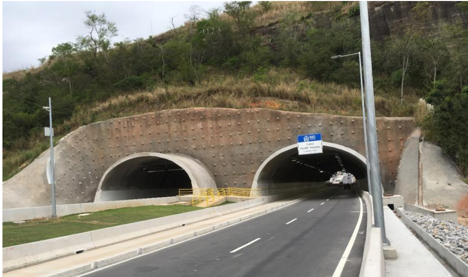
Figura 4.17 Estabilização por solo grampeado ( soil nailing )
