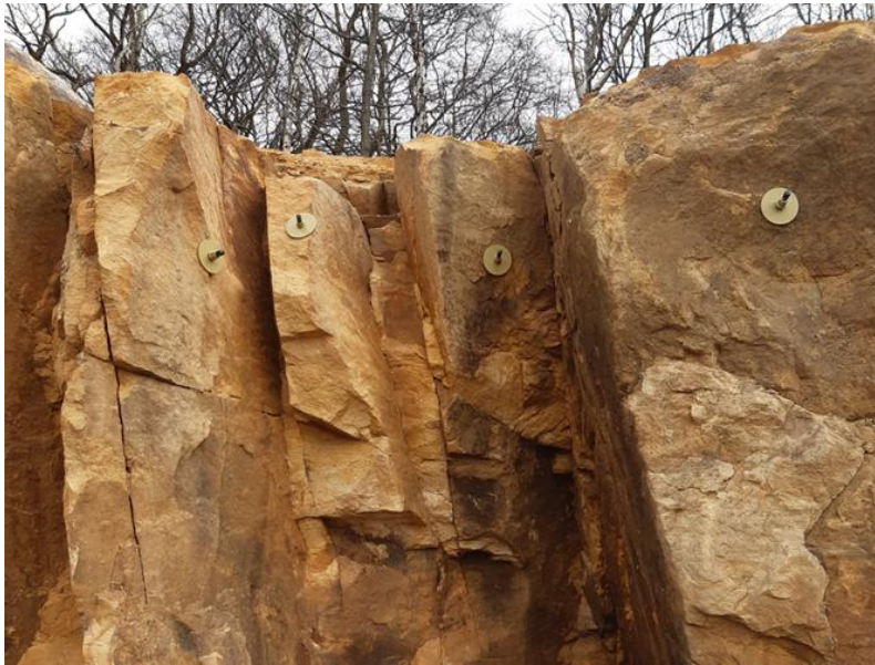
Figura 4.20 Estabilização de blocos de rocha
