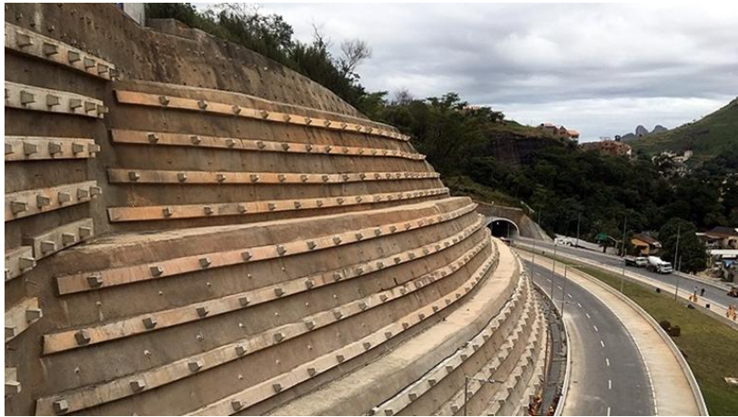
Figura 4.18 Estabilização por cortinas atirantadas
