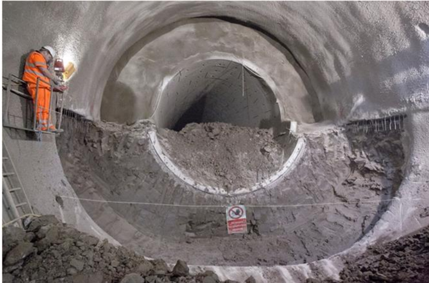
Figura 4.44 Utilização de túnel piloto
