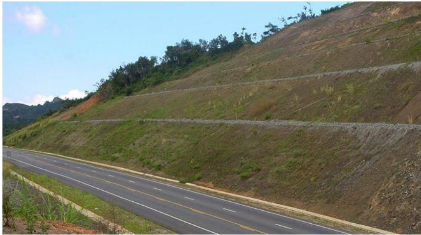
Figura 4.15 Estabilização por retaludamento
