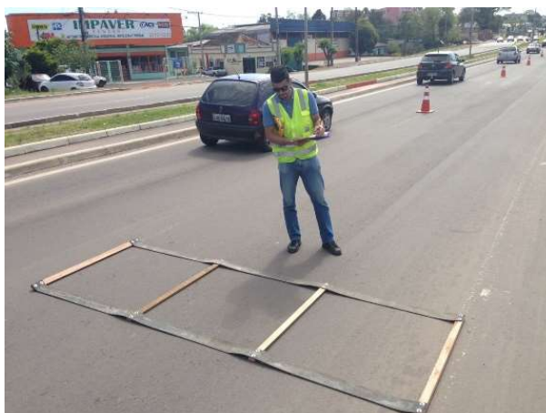
Figura 11 – Execução do levantamento dos defeitos
