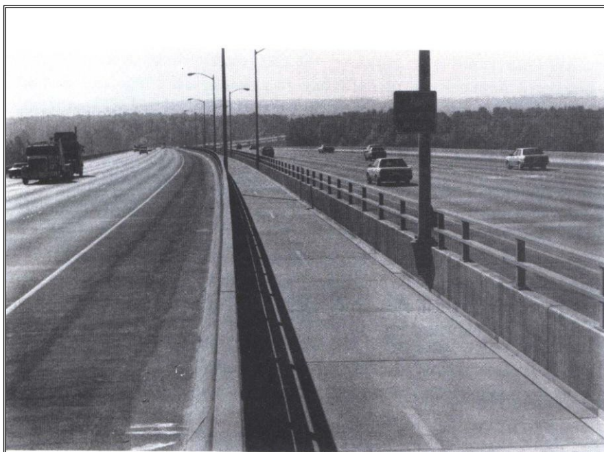
Figura 25 – Ciclovía em viaduto
