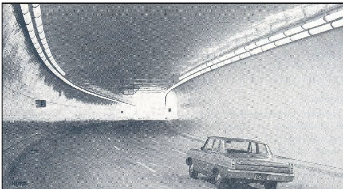
Figura 110 – Túnel de três faixas de sentido único
